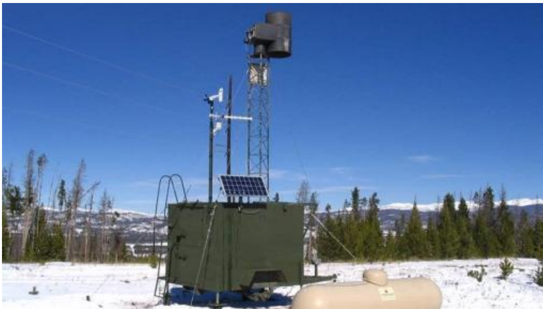
Εικόνα 7 Μια επίγεια γεννήτρια συμπύκνωσης νεφών που λειτουργεί από το Ινστιτούτο Desert Research σε γη που ανήκει στο Denver Water, βόρεια του Winter Park Resort με σκοπό την ενίσχυση της χιονόπτωσης. Πηγή: (Quinton, 2018)
