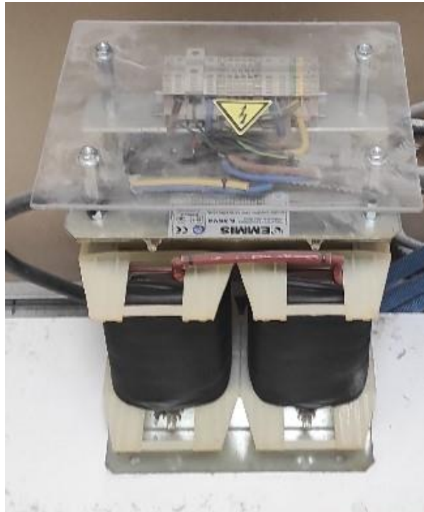
Εικόνα μετασχηματιστής απομόνωσης.
