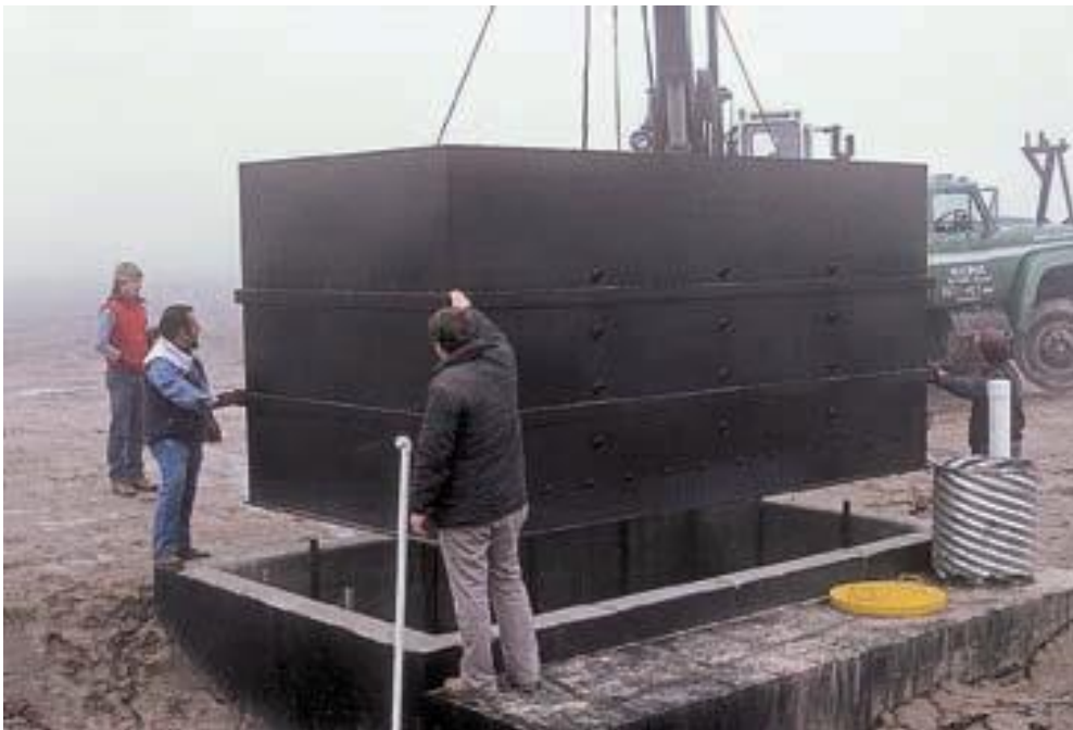
Εικόνα 13. Τοποθέτηση Δοχείου που φέρει έδαφος και φυτά στον Τσιμεντένιο Θάλαμο, πηγή: Johnson et al. (2005)
