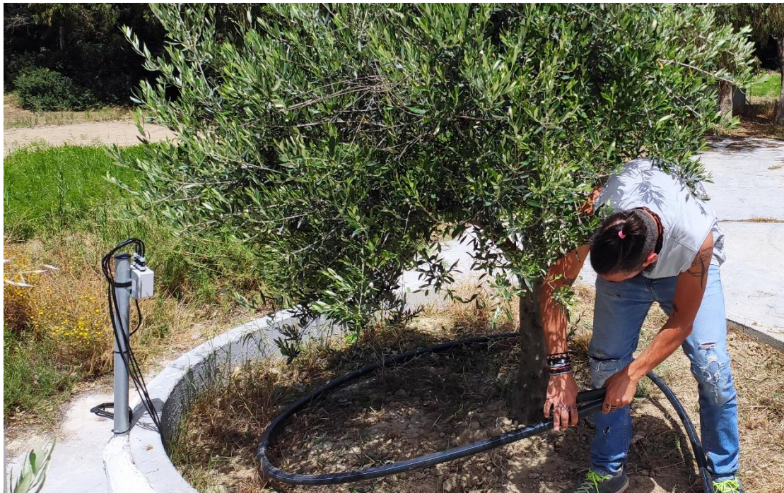
Εικόνα 47: Εγκατάσταση αρδεντικού εξοπλισμού στα λυσίμετρα.
