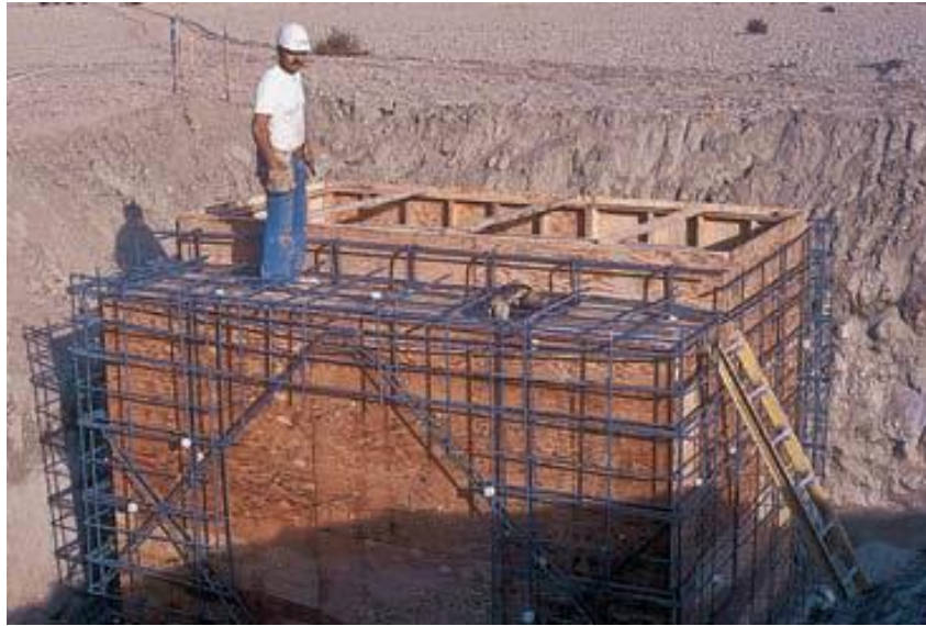
Εικόνα 12. Κατασκευή Τσιμεντένιου Θαλάμου, πηγή: Johnson et al. (2005)
