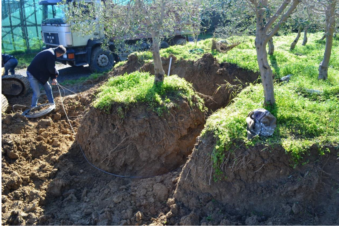
Εικόνα 40. Εκσκαφή για την μεταφορά των δέντρων.
