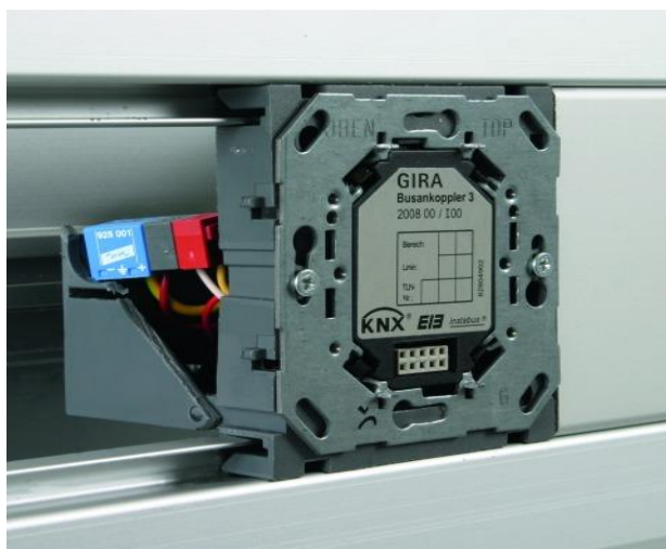
Εικόνα 113. Τοποθέτηση κλέμματος προστασίας από υπερτάσεις σε χωνευτό bus συνδρομητή 47
