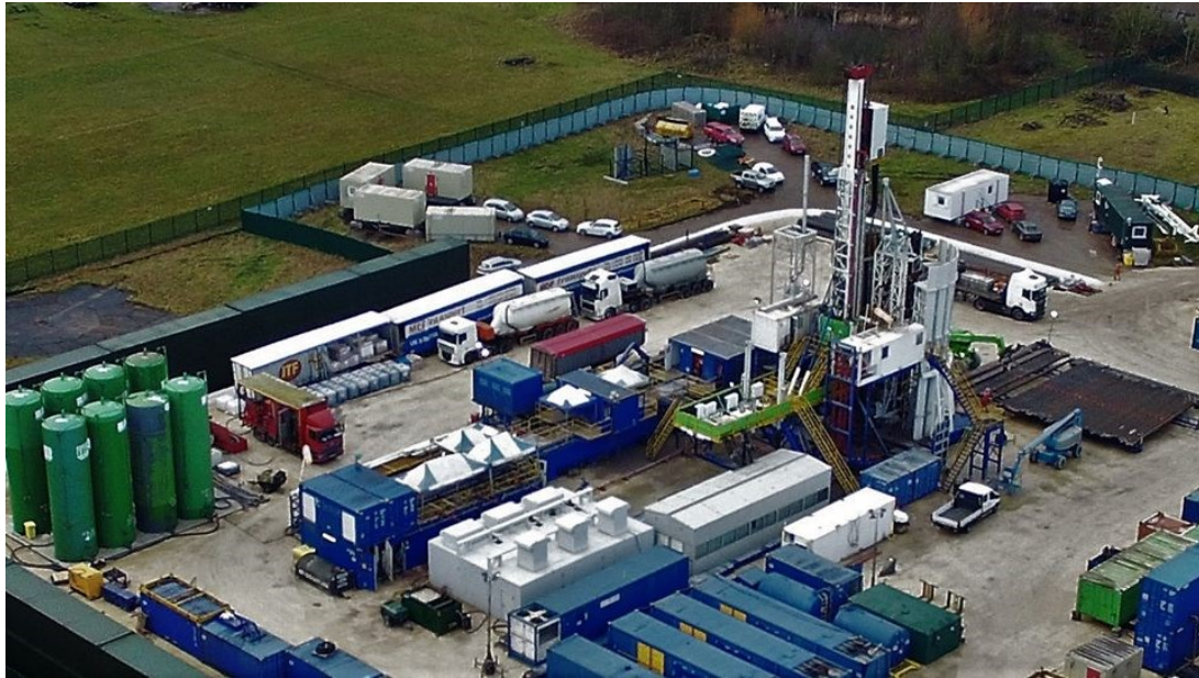
Εικόνα 4 Υδραυλική ρωγμάτωση παραγωγής σχιστολιθικού αερίου της IGas στο Misson, Nottinghamshire. (Φωτογραφία: Eric Walton)
