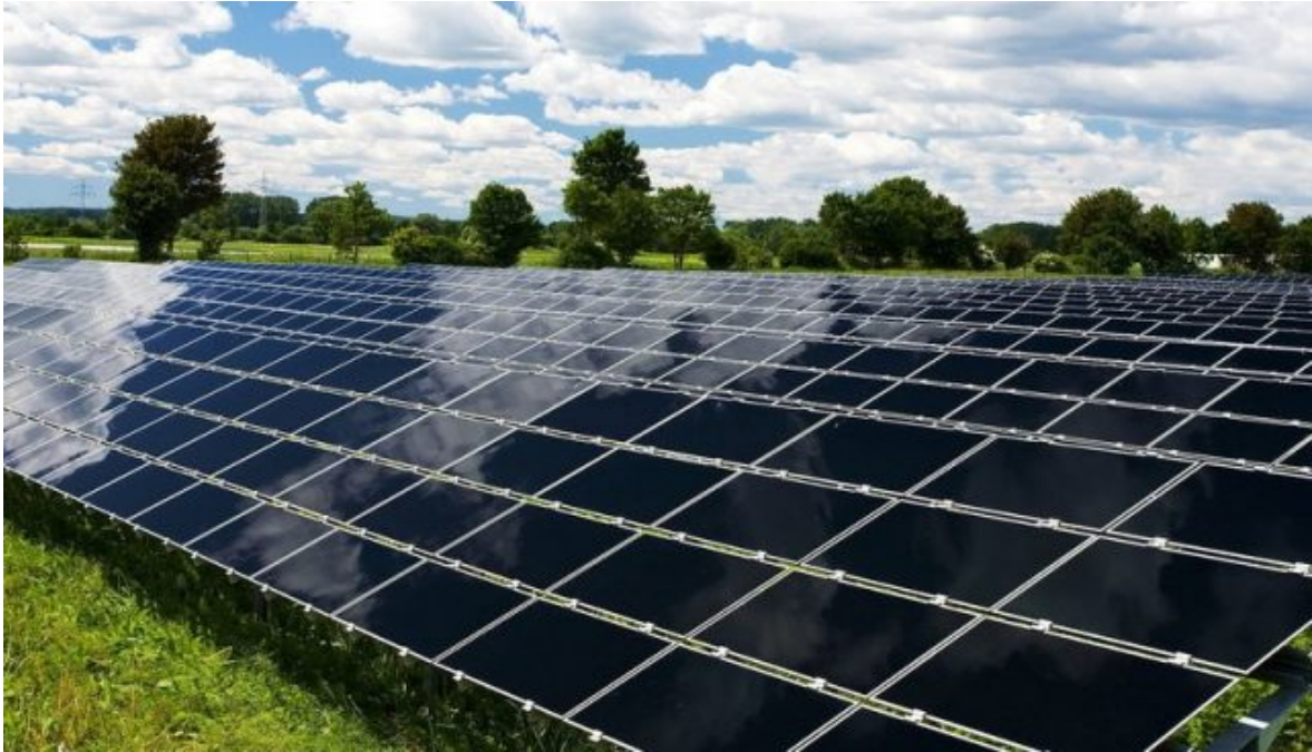
Σχήμα 1.41 Άμορφα Φ/Β πλαίσια Λεπτού Υμενίου (a-Si thin film)
