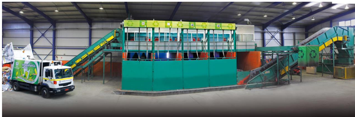
Εικόνα 20: Κέντρο Διαλογής Ανακυκλώσιμων Υλικών (ΚΔΑΥ). [35]
