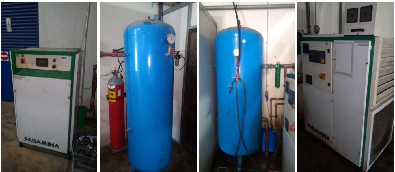
Εικόνες 1-2-3-4 : Πιεστικό σύστημα ΑΕΡΑ με τους θαλάμους αποθήκευσης για το Συσκ. και ότι Πνευματικό σύστημα υπάρχει.
