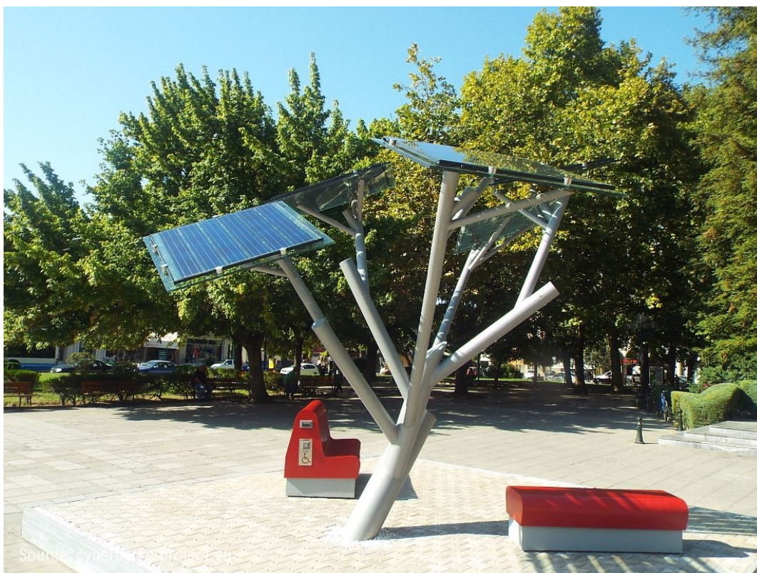
Εικόνα 7: Καινοτομία στα Τρίκαλα, με φωτοβολταϊκά πάνελ σε μορφή δέντρου να προσφέρουν σκίαση αλλά και ηλεκτρική ενέργεια από ανανεώσιμες πηγές (πηγή: διαδίκτυο)
