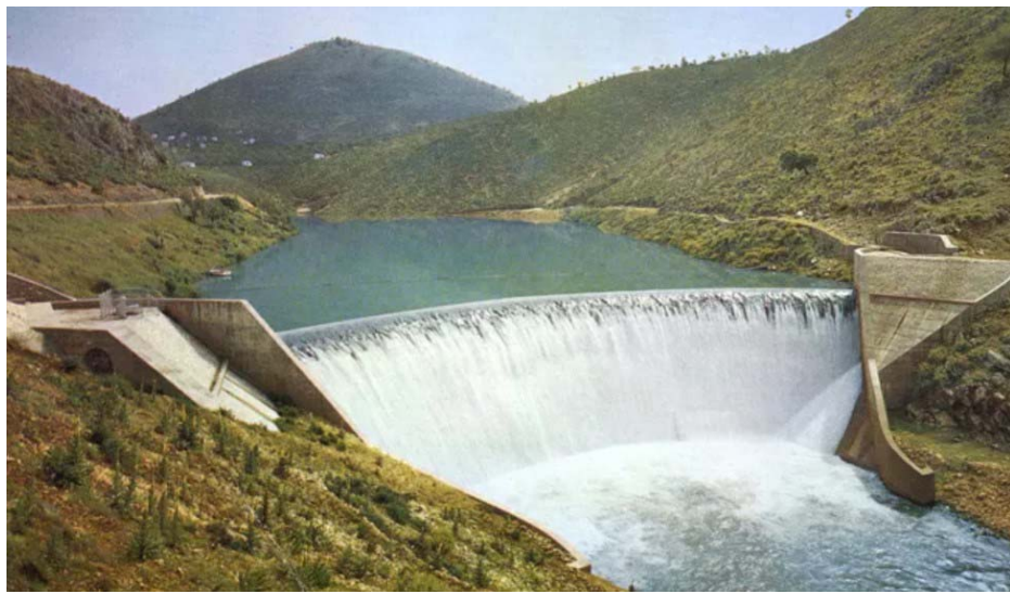
Εικόνα 2.3: Η τεχνητή λίμνη του Υδροηλεκτρικού Σταθμού Λάδωνα Αρκαδίας, Πηγή: https://www.dei.gr/el/dei-omilos/i-dei/istoriki-diadromi/
