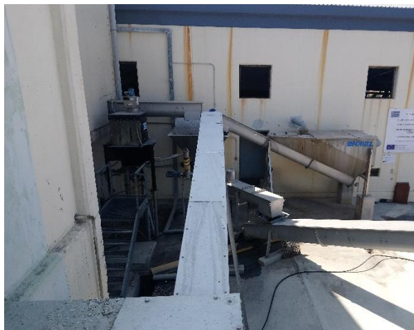
Εικόνα 17 Σύστημα διαχείρισης εσχαρισμάτων μονάδων εσχάρωσης , λεπτοκοσκίνησης και εξάμμωσης
