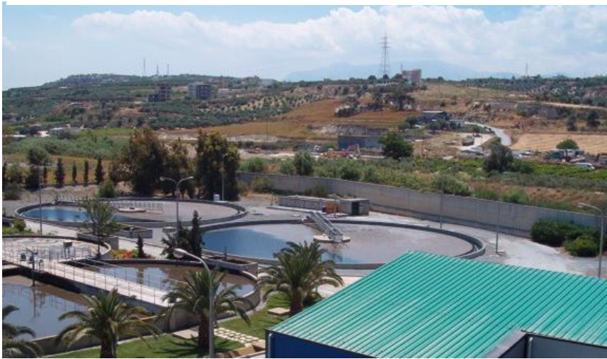
Εικόνα 25 Δεξαμενές δευτεροβάθμιας καθίζησης ΜΕΛ Ηρακλείου
