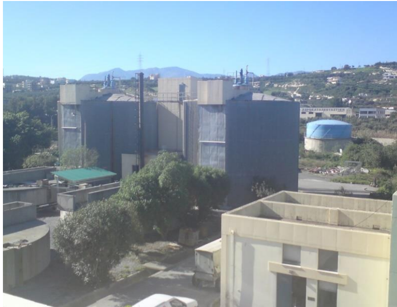
Εικόνα 29 Αναερόβιοι χωνευτές λυματολάσσης ΜΕΛ Ηράκλειου
