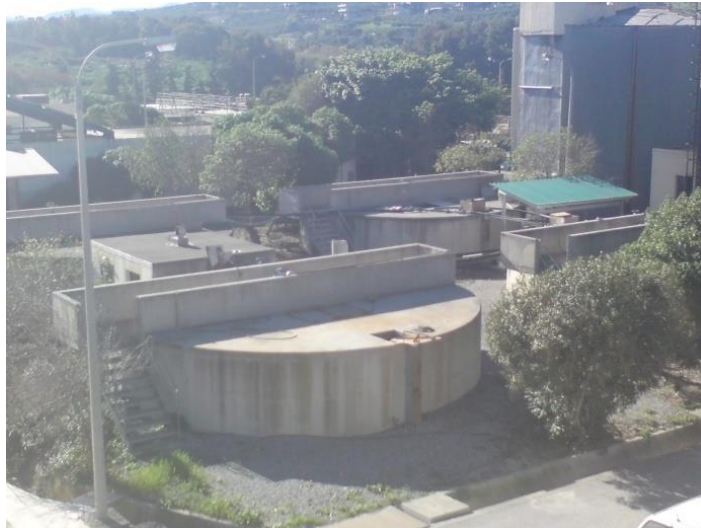
Εικόνα 27 Δεξαμενές πάχυνσης ΜΕΛ Ηρακλείου
