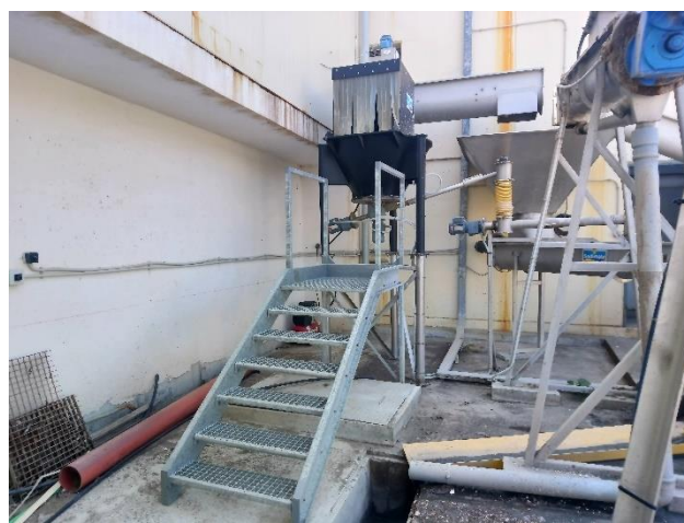
Εικόνα 17 Σύστημα διαχείρισης εσχαρισμάτων μονάδων εσχάρωσης , λεπτοκοσκίνησης και εξάμμωσης
