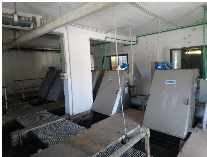
Εικόνα 16 Κτήριο εσχάρωσης ΜΕΛ Ηρακλείου Πηγή ΔΕΥΑΗ
