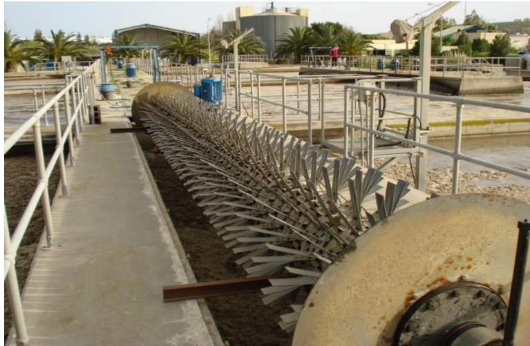
Εικόνα 26 Επιφανειακός αεριστήρας τύπου βούρτσας ΜΕΛ Ηρακλείου
