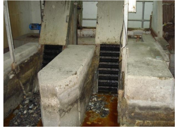
Εικόνα 16 Αυτοκαθαριζόμενες εσχάρες τύπου ταινίας Πηγή ΔΕΥΑΗ
