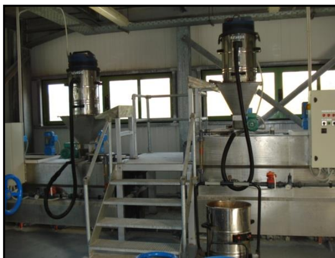
Εικόνα 33 Μονάδα προετοιμασίας πολυηλεκτρολύτη ΜΕΛ Ηρακλείου
