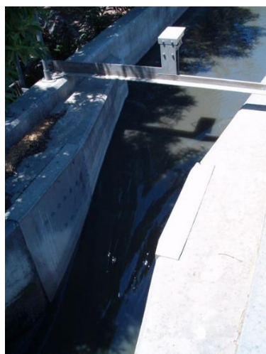
Εικόνα 21 Μετρητής παροχής τύπου Parshall ΜΕΛ Ηρακλείου
