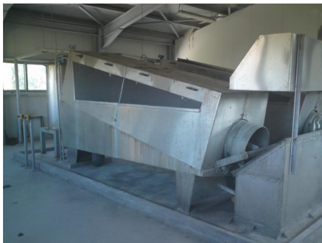
Εικόνα 35 Μηχανικοί παχυντές ΜΕΛ Ηρακλείου
