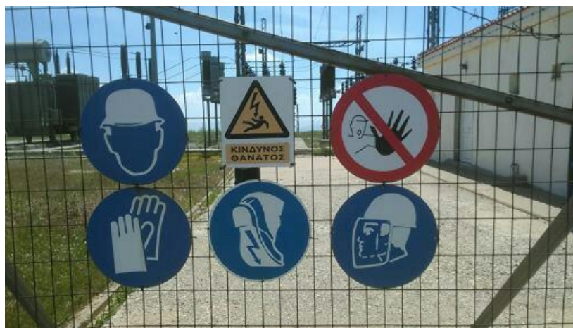
Εικόνα 6.5 Σημάνσεις ασφαλείας κατά την είσοδο στον υποσταθμό.
