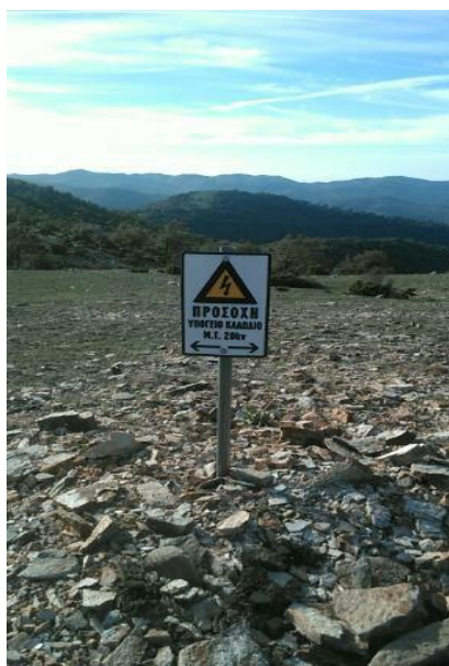
Εικόνα 6.3 Προειδοποιητική πινακίδα γραμμής υπόγειου ηλεκτρικού δικτύου.
