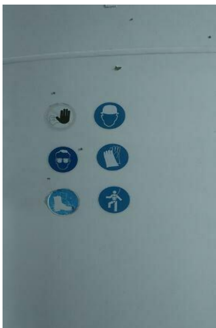
Εικόνα 6.1 Σημάνσεις ασφαλείας στη βάση του πύργου της Α/Γ.
