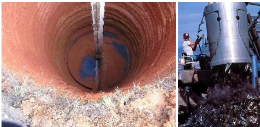
Εικόνα 3: Διάτρηση με την περιστροφική μέθοδο με κάδο (πηγή: thompsonbrothersdrilling.com)
