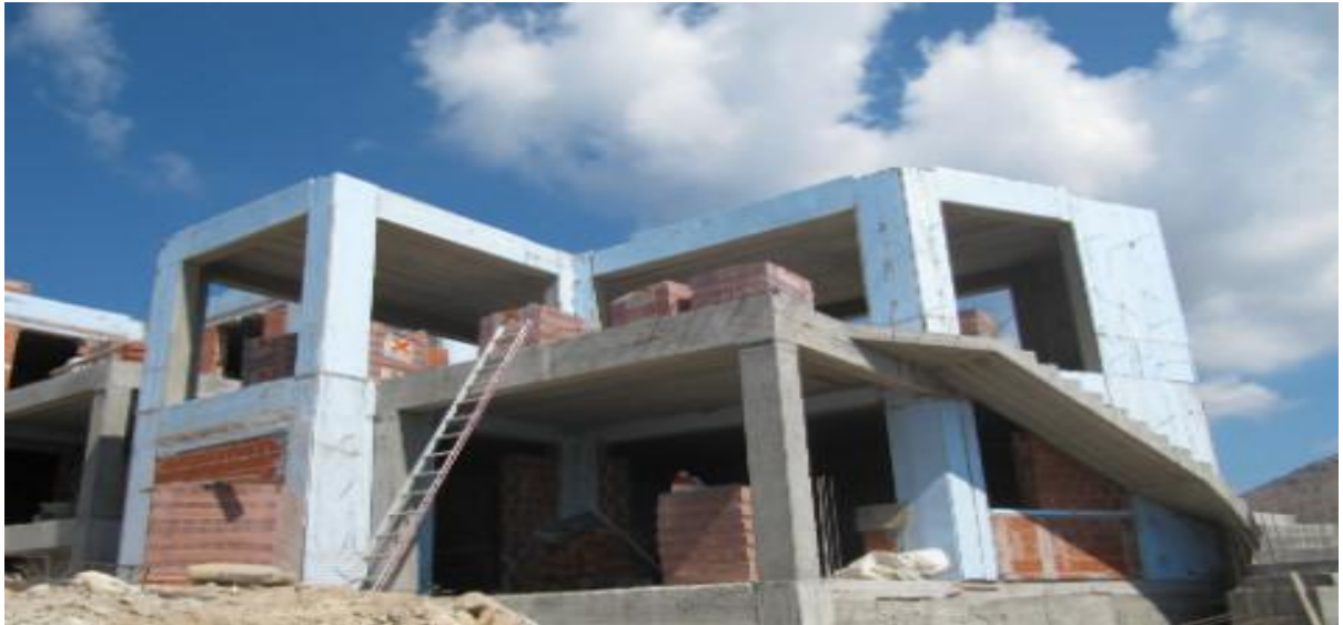
Εικόνα 9 Παράδειγμα μόνωση δομικών στοιχείων ενός κτιρίου
