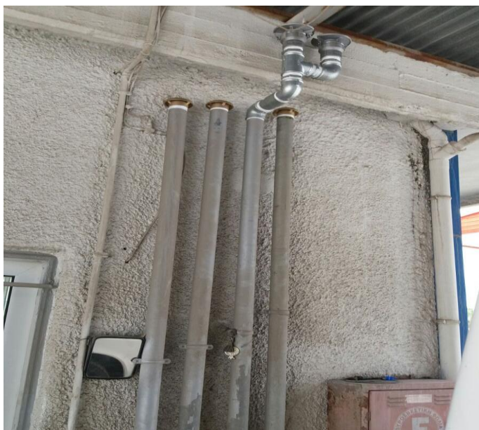
Εικόνα 7 Διάταξη Σωληνώσεων εξαερώσεως δεξαμενών
