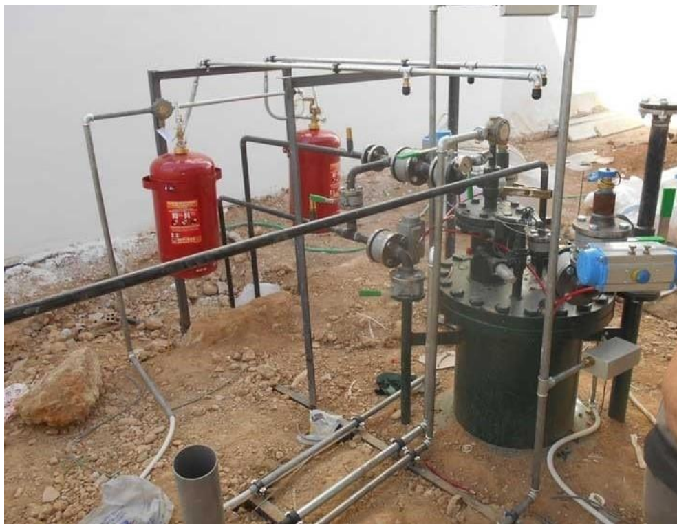
Εικόνα 28 Εγκατάσταση Μόνιμου Συστήματος πυρόσβεσης σε δεξαμενή LPG(Φωτογραφία(2)) [Πηγή: Ατεκε]
