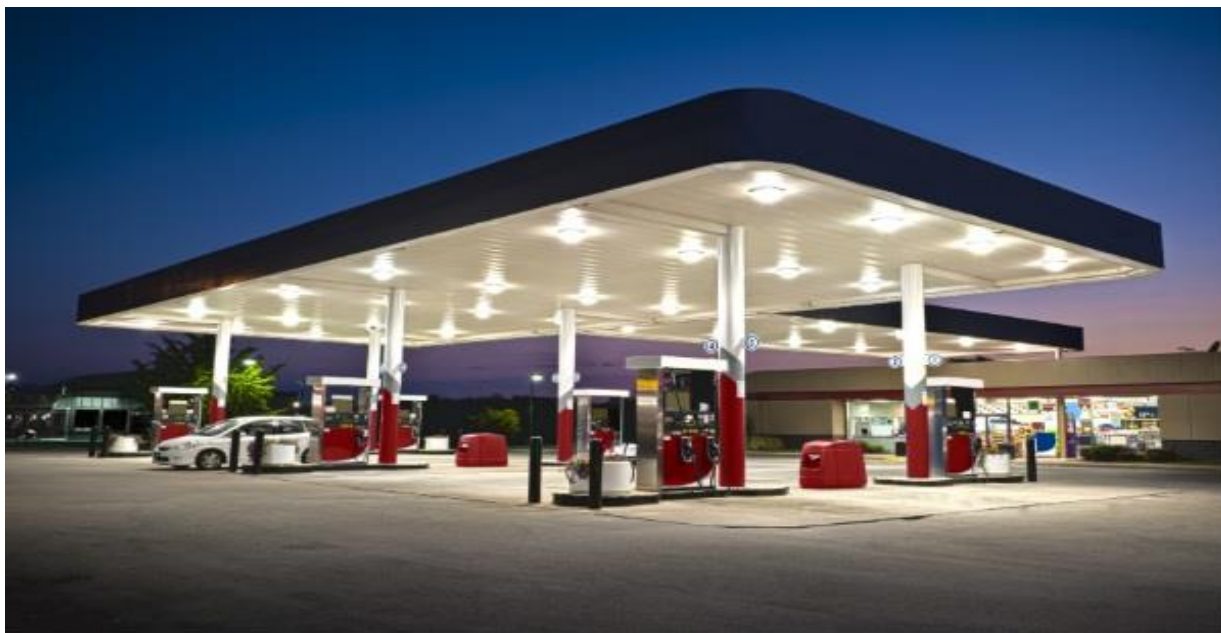
Εικόνα 1. «Πλατεία» πρότυπου πρατηρίου καυσίμων με στέγαστρο [Πηγή:Energypress.gr]
