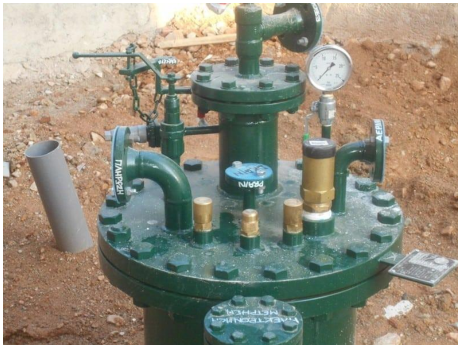
Εικόνα 19 Λεπτομέρεια ανθρωποθυρίδας δεξαμενής LPG
