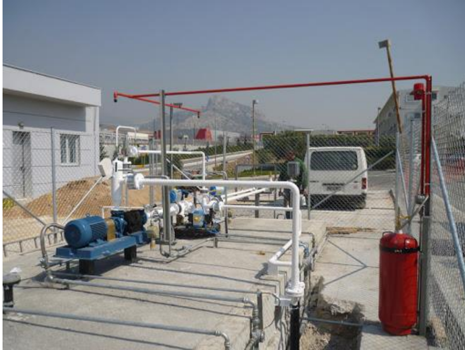
Εικόνα 27 Εγκατάσταση Μόνιμου Συστήματος πυρόσβεσης σε δεξαμενή LPG(Φωτογραφία1) [Πηγή: Ατεκε]
