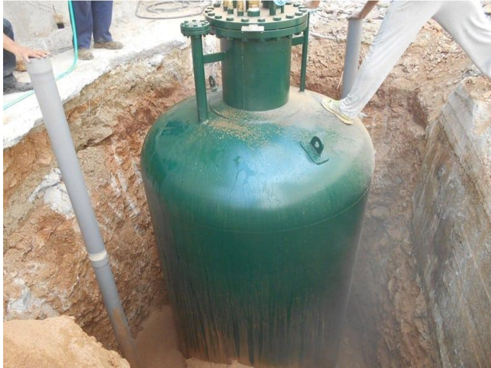
Εικόνα 18 Δεξαμενή υγραερίου (LPG) Χωρητικότητας 9.00m 3 (9.000lt)
