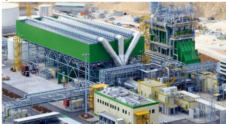
ΕΙΚΟΝΑ 1.4 : Νέα μονάδα συνδυασμένου κύκλου με Φυσικό Αέριο ισχύος 826 MW έξω από τη Θεσσαλονίκη
