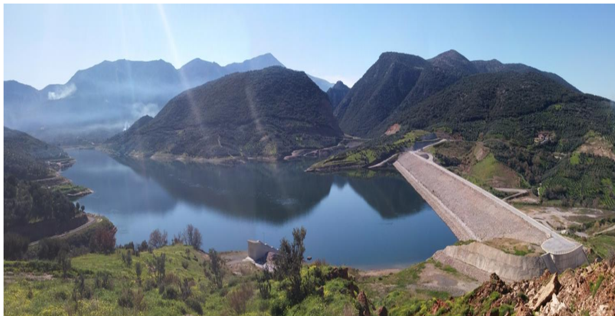
Εικόνα2.2 Ταμιευτήρας Φράγματος Αποσελέμη
