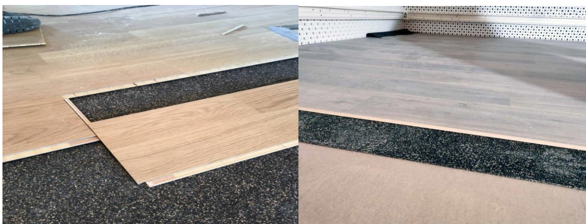
Εικόνα 23: Εφαρμογή πλωτού δαπέδου με ηχομονωτικό αντικραδασμικό ρολό
