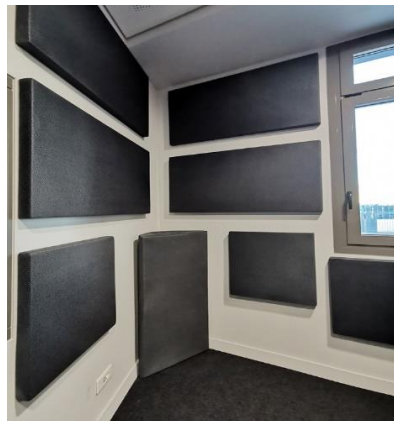
Εικόνα 20: Εφαρμογή μπασοπαγίδας σε δωμάτιο
