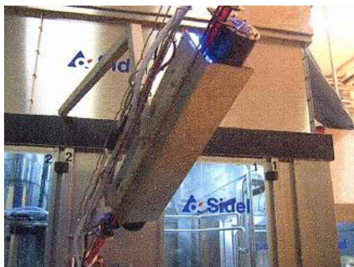
Εικόνα 37. Λυχνίες υπεριώδους ακτινοβολίας (UV) στη ράγα τροφοδοσίας πωμάτων
