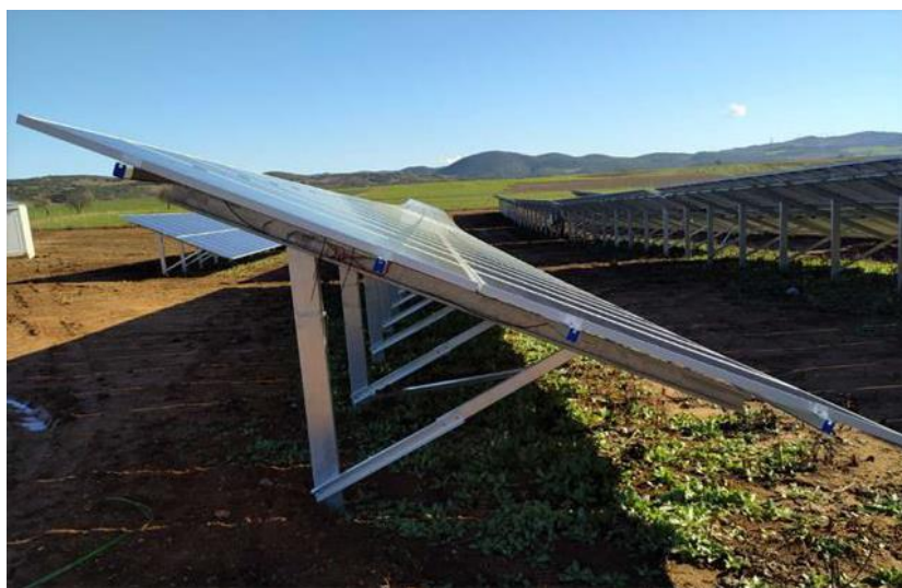
Figure 3.2 6: Μονοπάσσαλο Σύστημα Στήριξης
