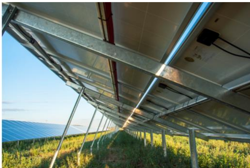
Figure 3.2 7: Διπάσσαλο Σύστημα Στήριξης
