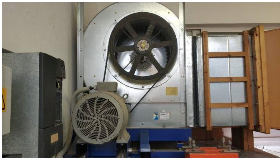
Εικόνα 18: Ο φυγοκεντρικός ανεμιστήρας μαζί με τον κινητήρα.
