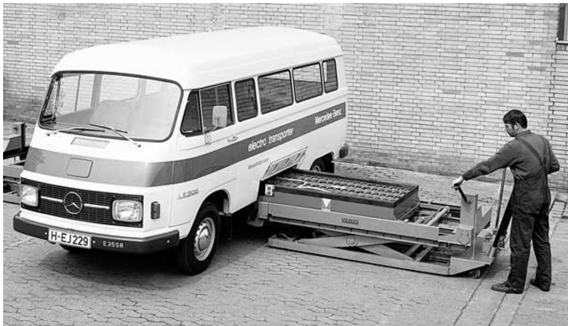
ΕΙΚΟΝΑ 1: ΑΝΤΙΚΑΤΑΣΤΑΣΗ ΜΠΑΤΑΡΙΩΝ ΗΛΕΚΤΡΙΚΟΥ ΟΧΗΜΑΤΟΣ ΚΑΤΑΣΚΕΥΑΣΜΕΝΟ ΑΠΟ ΤΗ MERCEDES ΤΗΝ ΔΕΚΑΕΤΙΑ ΤΟΥ 1970
