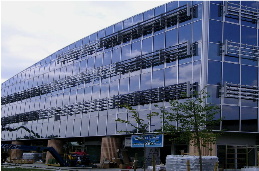
(σχήμα 22) Χρήση Φ/Β πάνελ ως σκίαστρα.
