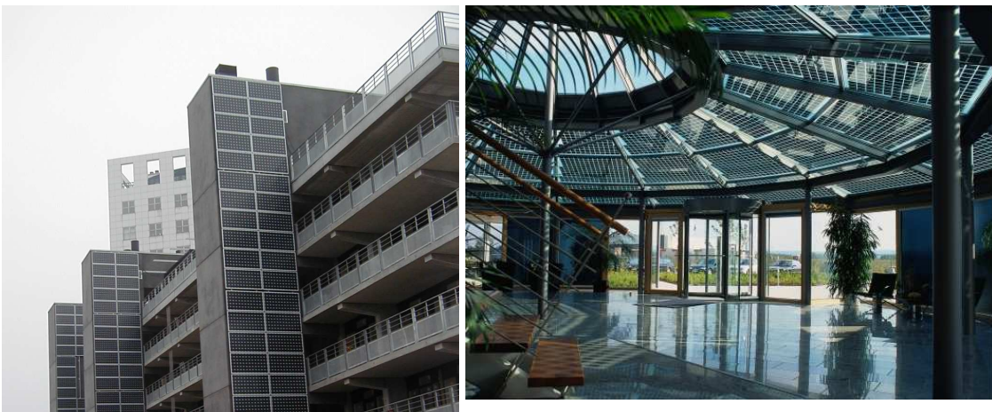
(σχήμα 20) Τοποθέτηση πάνελ σε εξωτερικούς τοίχους κτηρίου.
