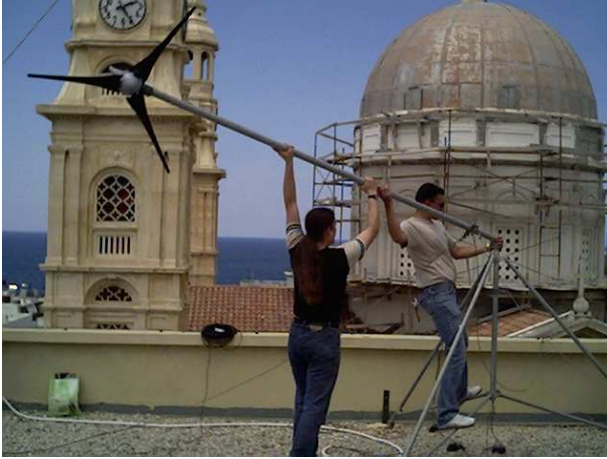
(σχήμα 45) Στήριξη της Α/Γ επάνω στο τρίποδο.
