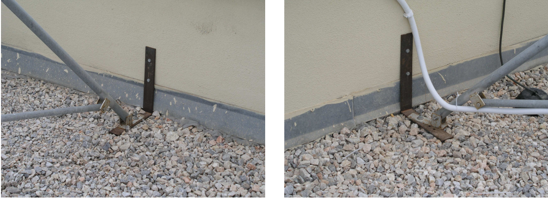
(σχήμα 41) Στήριξη τρίποδου σε μεταλλικές γωνιές
