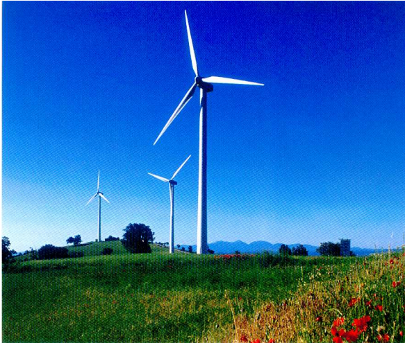
(σχήμα 10) Α/Γ VESTAS V-52 ισχύος 2 MW. VESTAS (2004). V-52 Booklet Denmark : VESTAS International Dept
