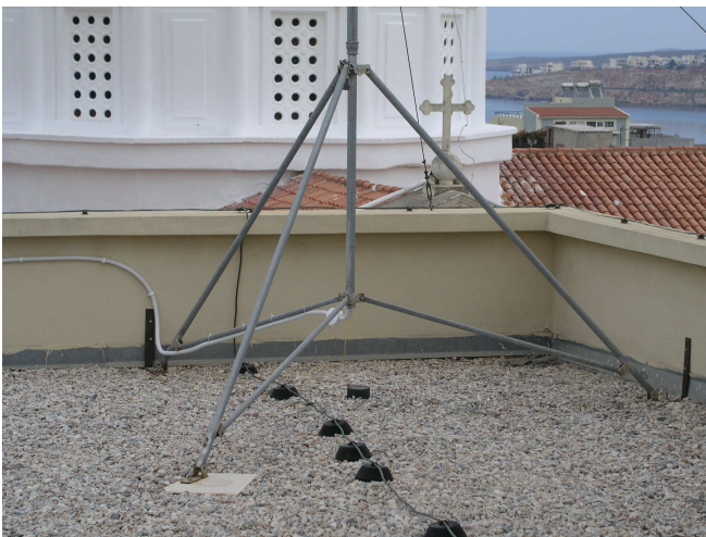
(σχήμα 42) Τελική τοποθέτηση τρίποδου στήριξης της Α/Γ
