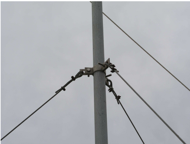
(σχήμα 46) Στερέωση του ιστού με τη χρήση αντηρίδων.
