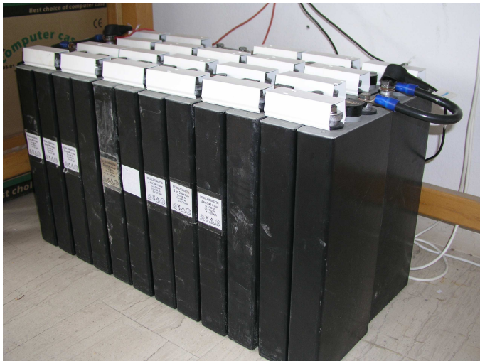
(σχήμα 60) Συσσωρευτές EpzS 240 Solar 2V οίκου Ceac-Fulmen Solar.
