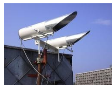
Εικόνα 37: Εγκατάσταση συστήματος Ronja
