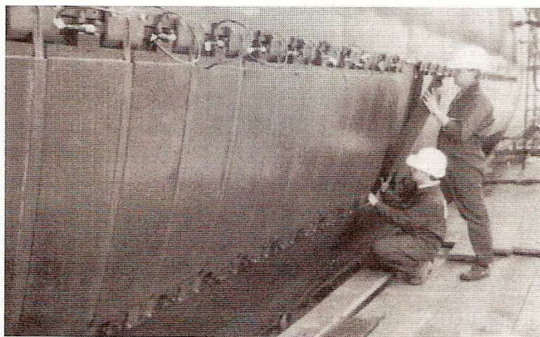
Διάταξη επίπεδων στοιχείων PVDF πλευρικής συστοιχίας υδροφώνων υποβρυχίου PFAS (Planar Flank Array Sonar).
