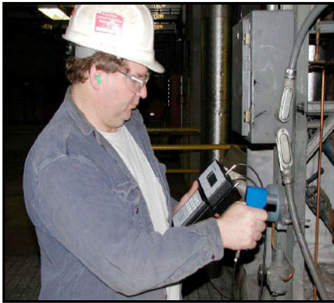
Εικ. 4.15 Ο ABP – 1 Airborne Probe στην ανίχνευση διαρροής αερίου
