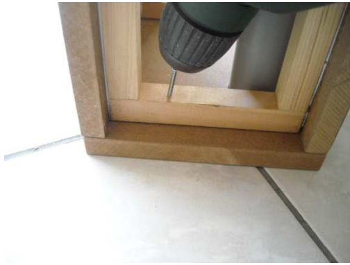
Σχήμα 6.33.Βίδωμα του επάνω μέρους για καλύτερη επαφή.
