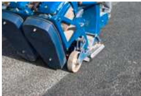
Εικόνα 3.5: Κοντινή όψη της διαδικασίας μικροεκτράχυνσης.
