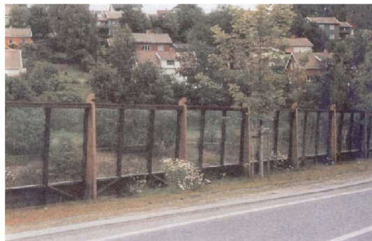
Εικόνα 1.15: Διαφανές ηχοπέτασμα με ξύλινα στοιχεία, για περιορισμό της αλλοίωσης της άποψης του περιβάλλοντος.
