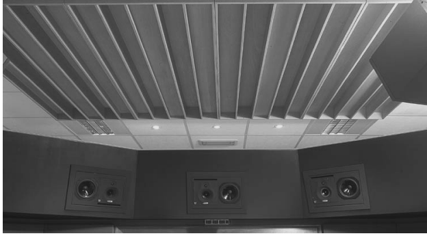
ΣΧΗΜΑ 24: Τοποθέτηση διαχυτών στο ταβάνι.
