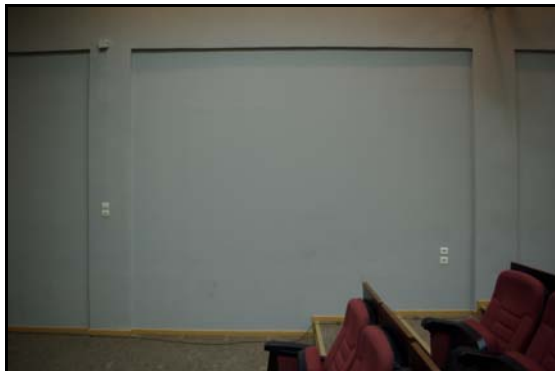
Σχήμα 5.8: Τμήματα γυψοσανίδας ανάμεσα στις κολώνες από μπετόν.
