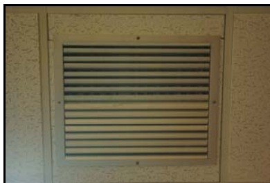
Σχήμα 5.6: Περσίδες εξαερισμού.
