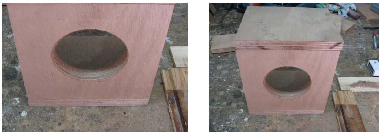
Σχήμα 4.1: Κατασκευή καμπίνας από marine plywood
