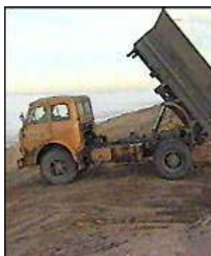
Εικόνα 6.30 Χρησιμοποιώντας τόνους χώματος, χτίζεται αργά ένα φράγμα
