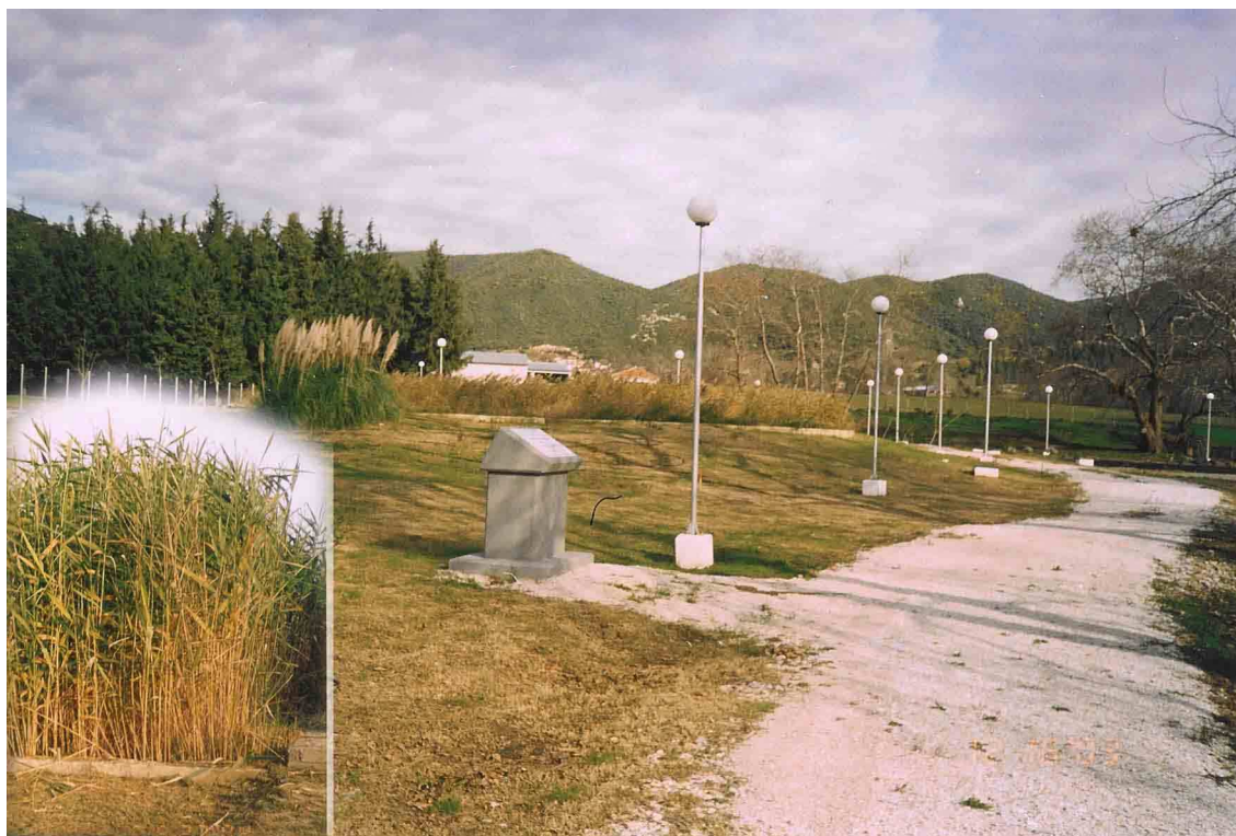
Εικόνα 8.1. Επεξεργασία Λυμάτων οικισμού Γοματίου [5].
