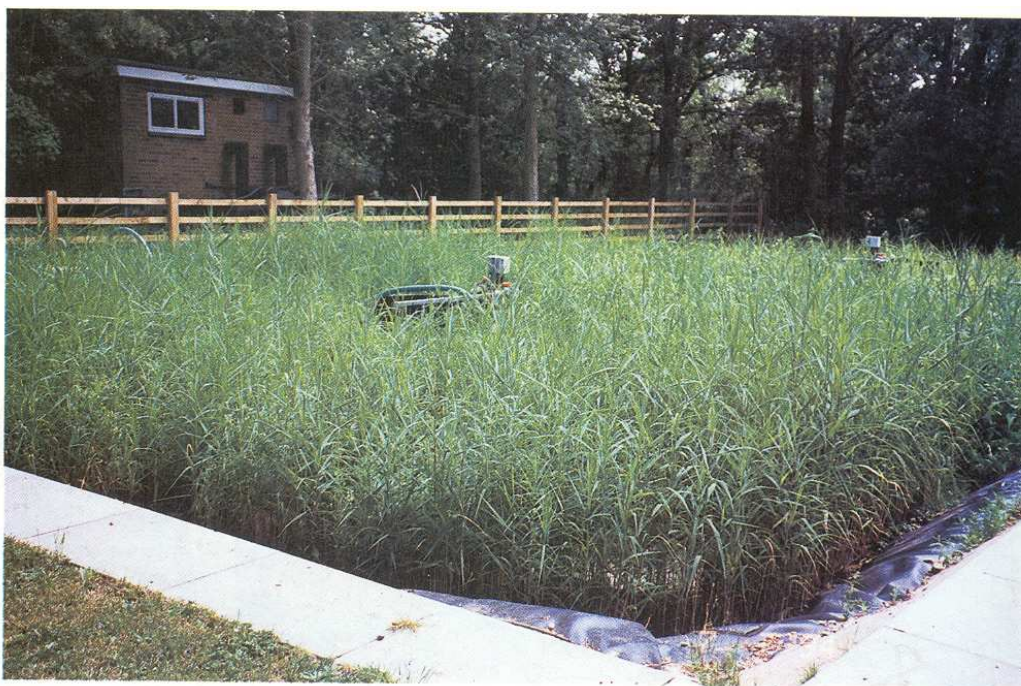
Σχ.4.10. Κλίνες καλαμιών κατακόρυφης ροής στο Medmenham τον Ιούλιο [4].
