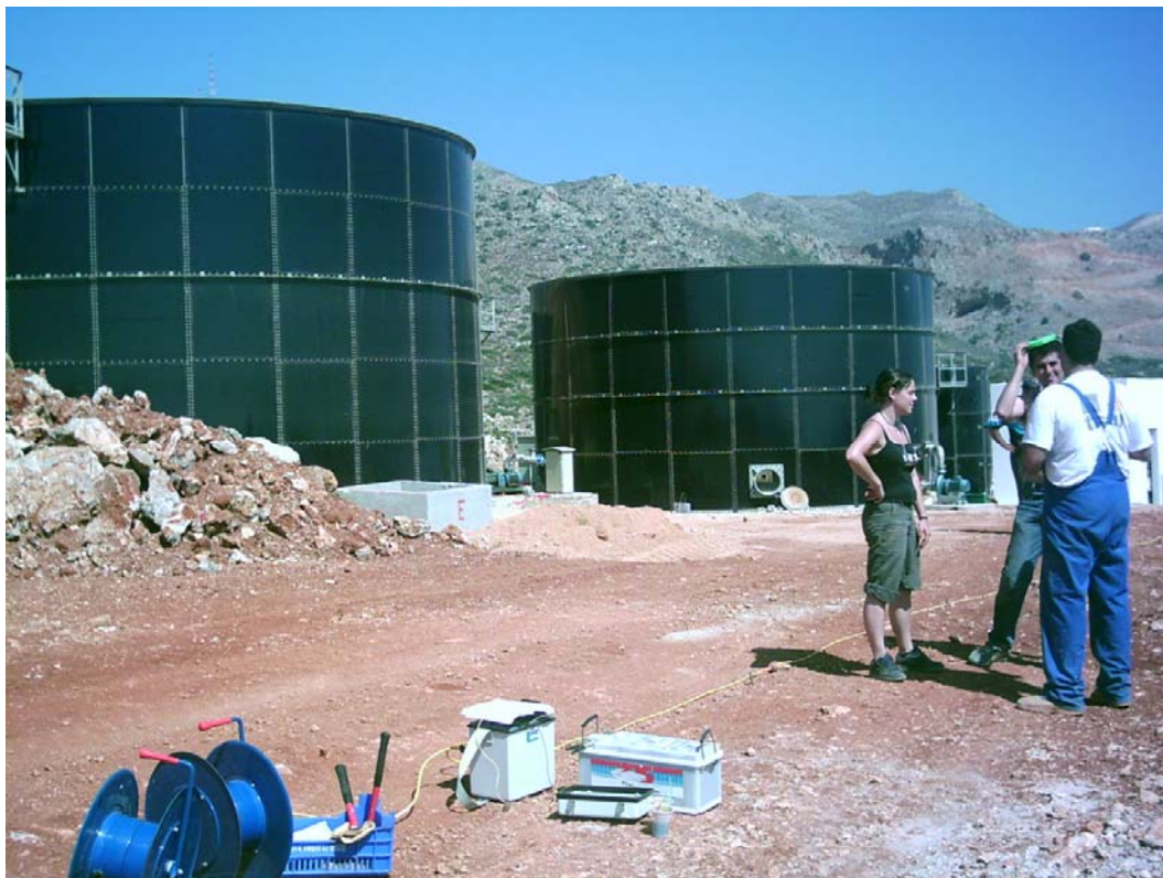
Σχήμα 67. Άποψη της γραμμής δύο. Αριστερά βλέπουμε τις τρεις δεξαμενές όπου συγκεντρώνονται τα διασταλάζοντα υγρά.
