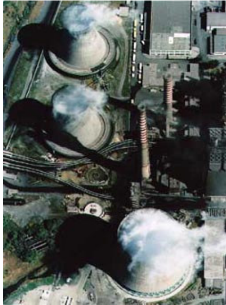
Σχήμα 2.4 Σταθμός Δ.Ε.Η. Μεγαλόπολης - Μονάδα III
