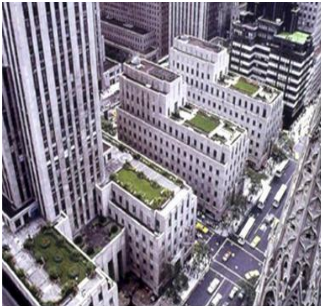
Εικόνα 3. Αεροφωτογραφία που απεικονίζει τις πέντε εντατικές πράσινες στέγες στο κέντρο του Rockefeller της Νέας Υόρκης.
