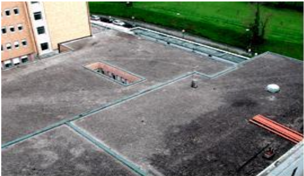
Εικόνα 22: Περιοχή τοποθέτησης πράσινης στέγης 29 .
