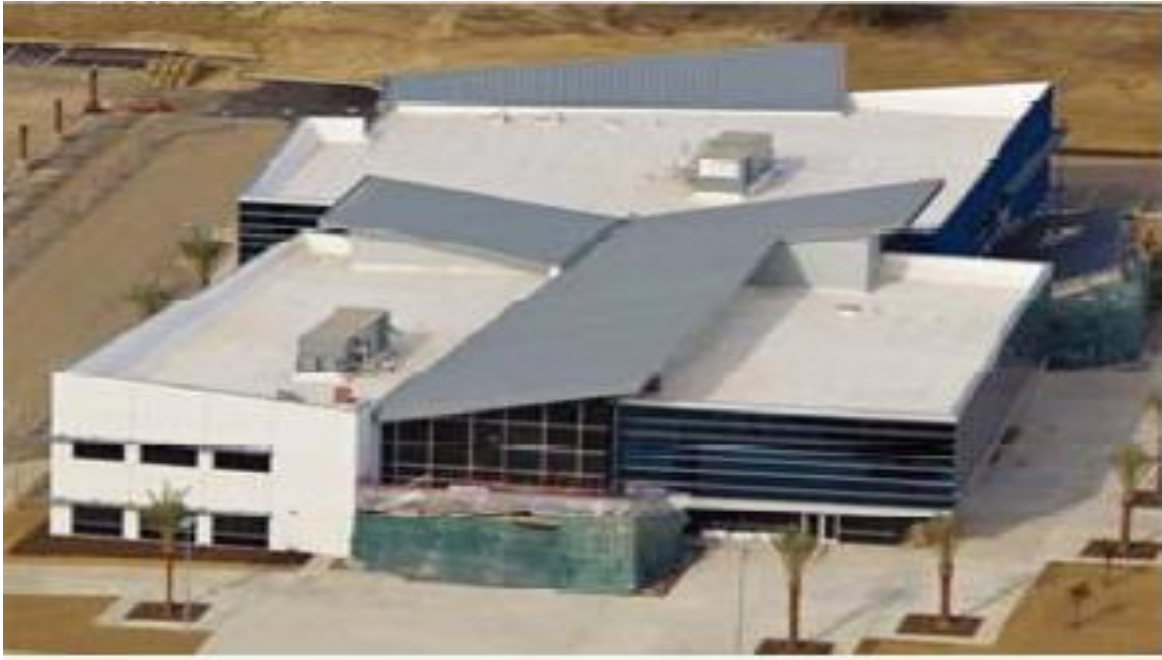
Εικόνα 48: Κτίριο με ψυχρές στέγες.
