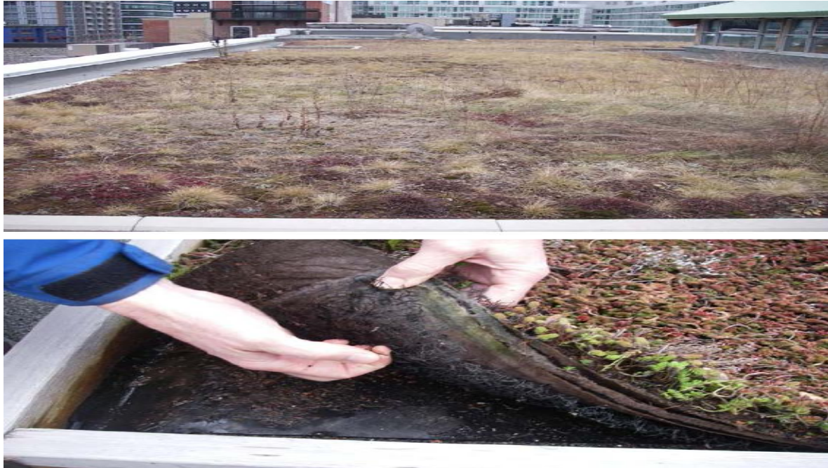
Εικόνα 14.Εκτενής στέγη στο κτίριο MEC στο Τορόντο.
