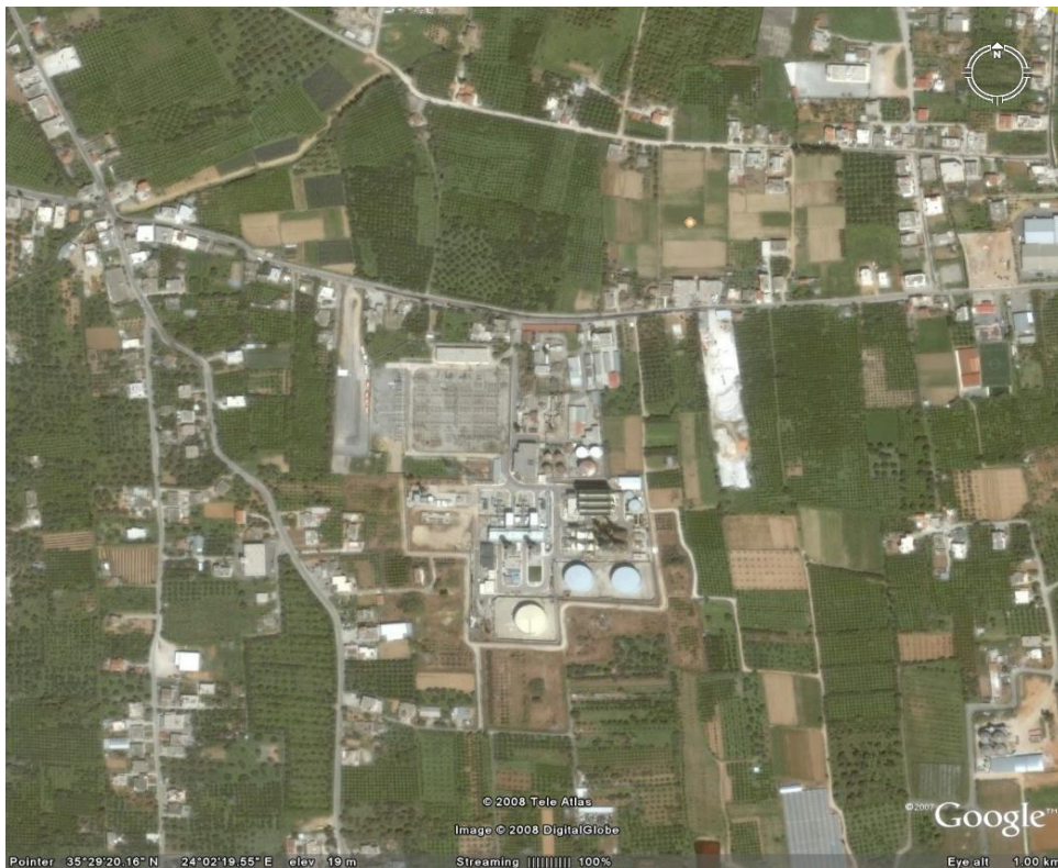
Σχήμα 1.2 Εικόνα του υποσταθμού ΔΕΗ Χανίων ( http://earth.google.com/ )
