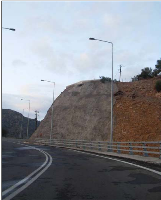
Εικόνα 13: Εκτόξευση σκυροδέματος σε πρανές στο οδικό δίκτυο Κανδάνου – Παλαιόχωρας.
