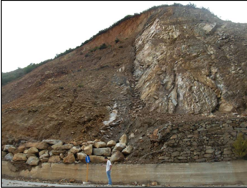
Εικόνα 40: Κατολίσθηση στο οδικό δίκτυο Χανίων –Σούγιας, περιοχή Λάγγος.
