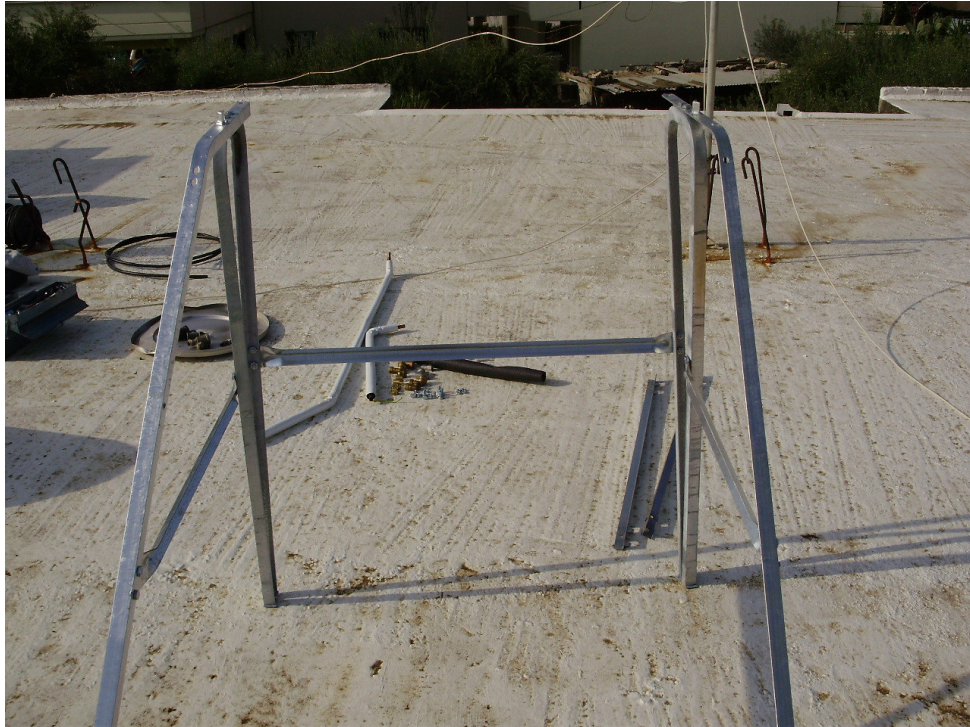
Εικόνα 4.14 Συναρμολόγηση της βάσης
