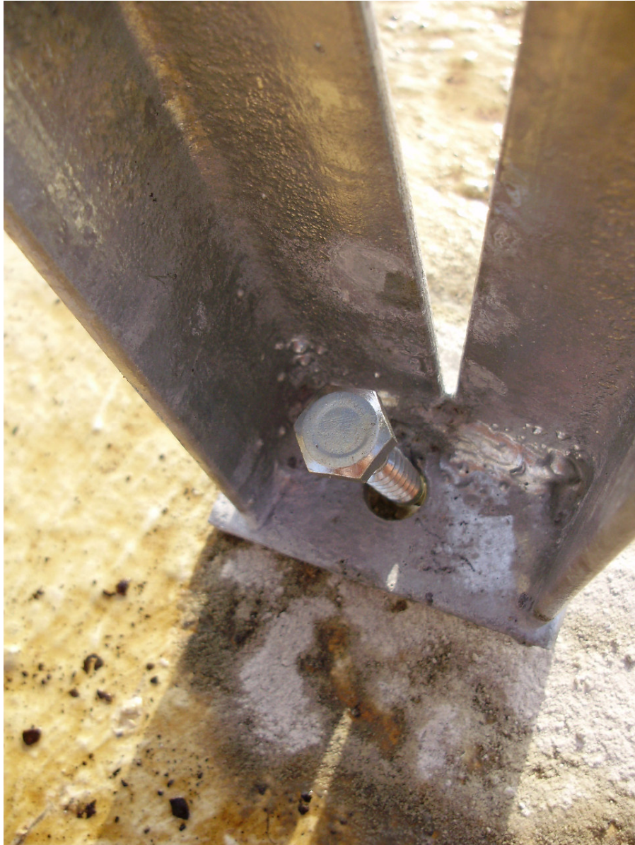
Εικόνα 4.19 Στήριξη της βάσης στο μπετόν της τaráτσας και στην συνέχεια επικάλυψη με μονωτικό υλικό για την αποφυγή εισροής υγρασίας.
