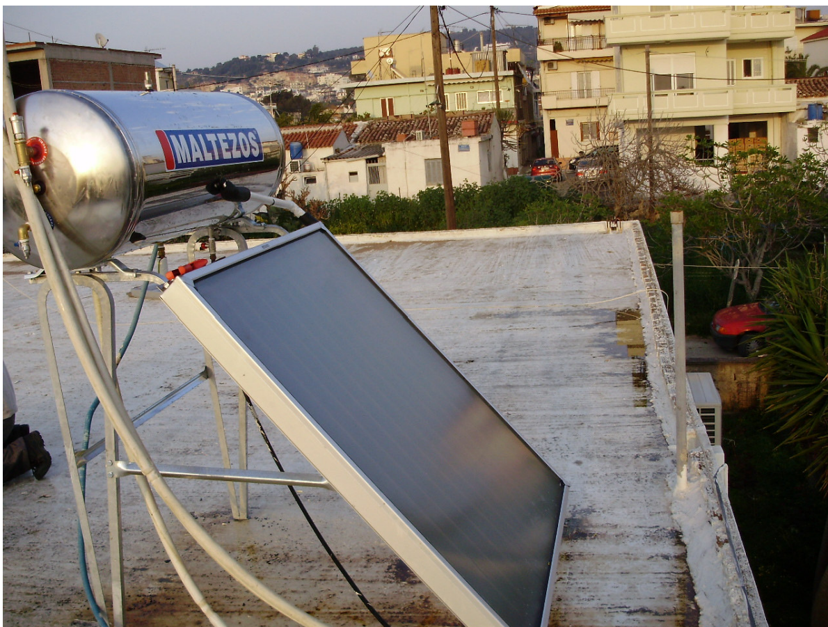
Εικόνα 4.29 Σύνδεση λάστιχων πολυαιθυλενίου με μόνωση στην κεντρική θέρμανση και πλήρωση του μπόιλερ με αντιπηκτικό υγρό και νερό, και έτοιμο προς δοκιμή και χρήση.
