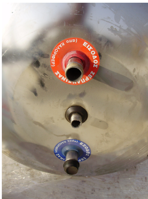
Εικόνα 4.23 Επικάλυψη των σπειρωμάτων με κανάβι και τεφλόν στον εναλλάκτη.(η στεγανοποίηση των σπειρωμάτων μπορεί να γίνει και με υγρό τεφλόν)
