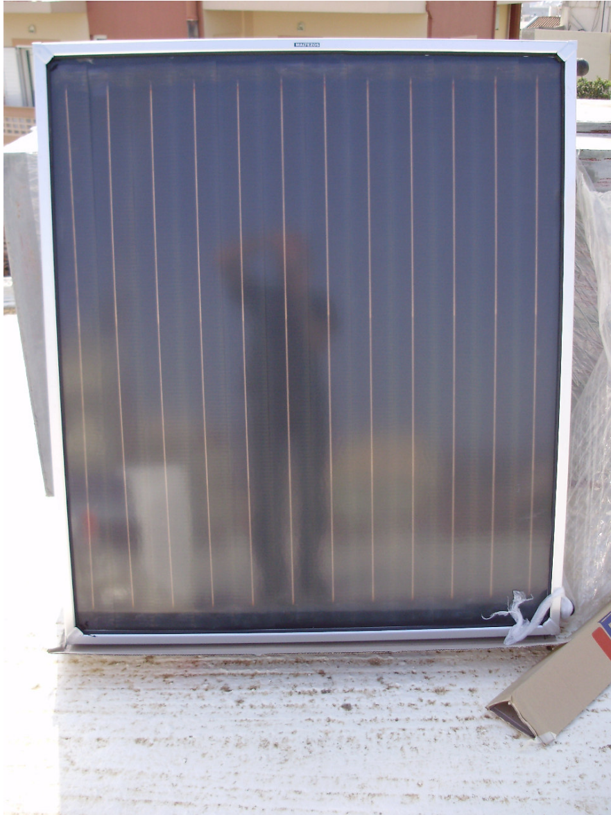
Εικόνα 4.16 Ο συλλέκτης σε όλη την διάρκεια της τοποθέτησης πρέπει να είναι σε σκιερό μέρος και να σκεπάζεται όταν τοποθετείται στη βάση του, έως να γίνει η πλήρωση του με νερό.
