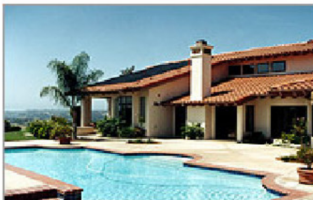
Εικόνα 5.3 Ηλιακή θέρμανση πισίνας στη Σκαφιδιά Ηλείας.
