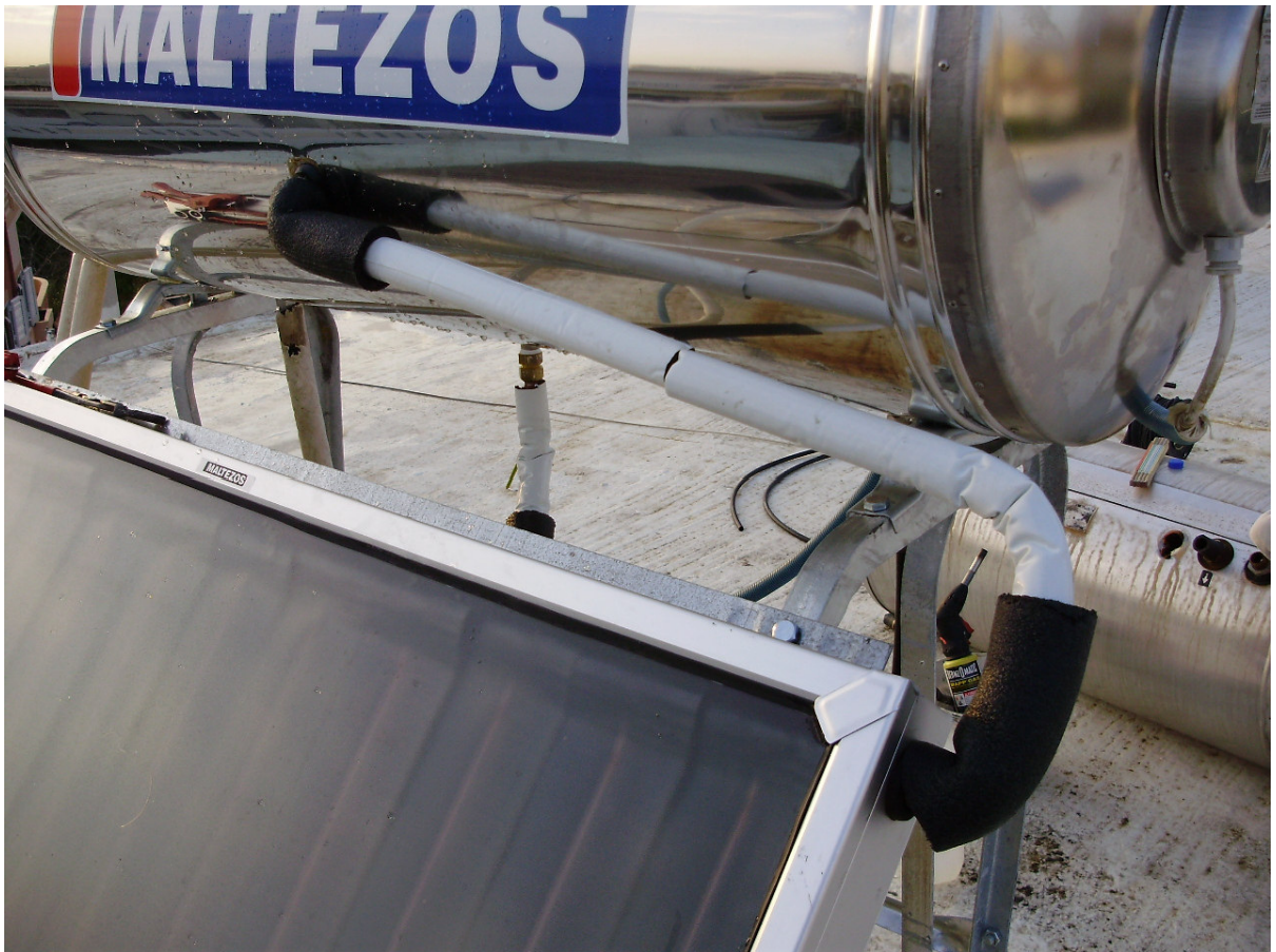
Εικόνα 4.27 Τοποθέτηση μονώσεων.
