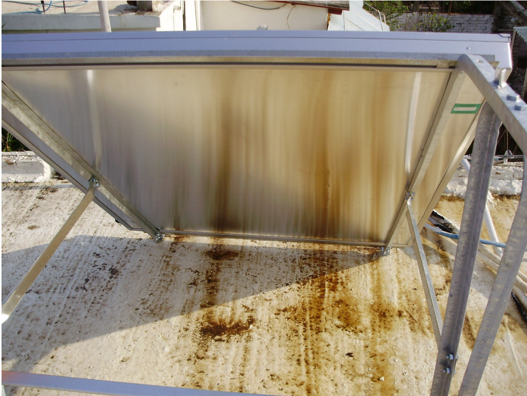
Εικόνα 4.17 Τοποθέτηση του συλλέκτη(4 τυφλές οπές με σπείρωμα) πάνω στην βάση, ένωση μεταξύ τους (4 κοχλίες) και αλφάδιασμα της βάσης.
