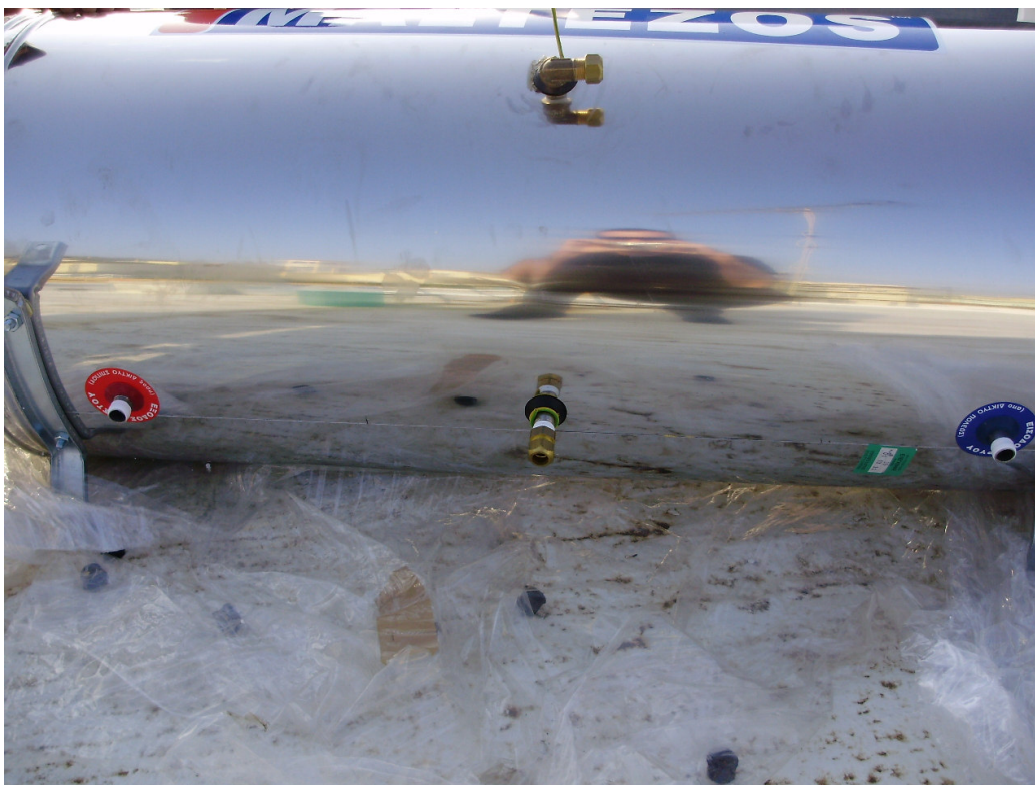
Εικόνα 4. 22 Επικάλυψη των σπειρωμάτων με κανάβι και τεφλόν και τοποθέτηση των εξαρτημάτων(η στεγανοποίηση των σπειρωμάτων μπορεί να γίνει και με υγρό τεφλόν).
