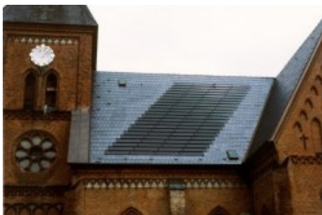
Σχήμα 5.2: Προσανατολισμός των πλασιών σε σειρές σε στέγη εκκλησίας
