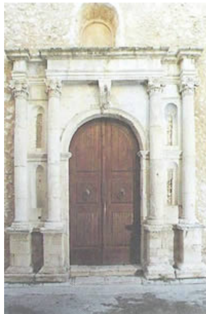
Σχήμα 49 Το εντυπωσιακό θύρωμα του τζαμιού στην οδό Εμμ. Βερνάρδου. ζευγάρι παραστάδων με απλά επίκρανα και καταλήγει σε ένα ιδιαίτερα τονισμένο φουρούσι που αντικαθιστά το κλειδί.
