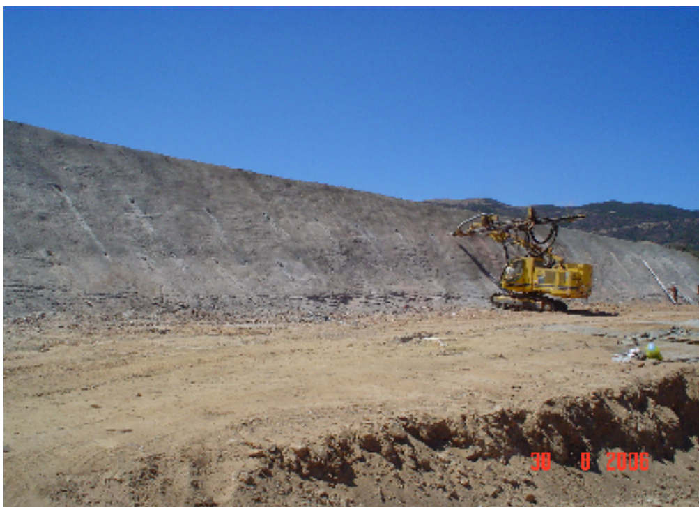
Φωτογραφία 3. Διάφραγμα τσιμεντέσεων που αποσκοπεί στην στεγανότητα του φράγματος
