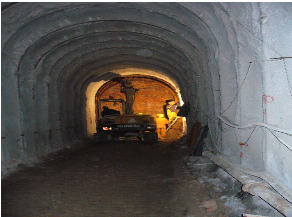
Φωτογραφία 4. Κατασκευή σηράγγων με σκοπό την διευκόλυνση στη μετακίνηση και μεταφορά εξοπλισμού καθώς και ασφαλείας του φράγματος σε περίπτωση δυσμενούς ανάγκης.
