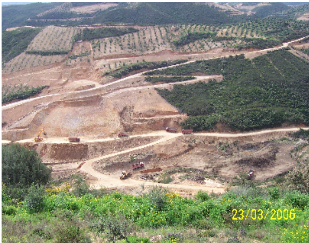
Φωτογραφία 2. Αρχικά στάδια μεταφοράς σκληρού επιχώματος στο φράγμα Βαλσαμιώτη.
