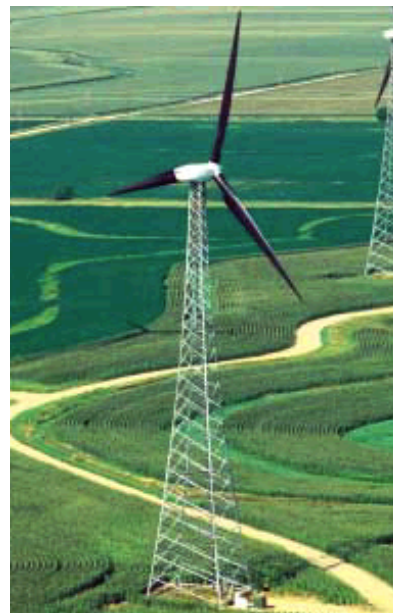
Σχήμα 2.8. Α/Γ με σωληνωτό χαλύβδινο πύργο (αριστερά) και δικτυωτό πύργο (δεξιά)(2)
