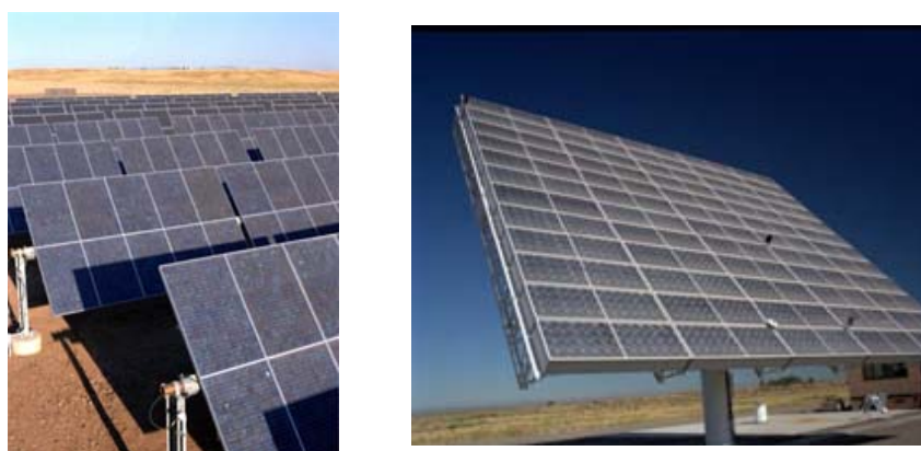
Σχήμα 3.14. Παρακολούθηση τροχιάς μονού άξονα (αριστερά) και συγκεντρωτικές κυψέλες με παρακολούθηση τροχιάς διπλού άξονα (δεξιά) [Πηγή: http://aurora.crest.org/pv/array/components/index.htm ]
