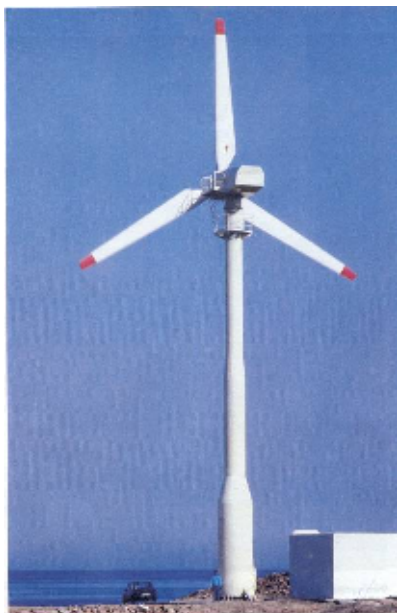
Σχήμα 2.8. Α/Γ με σωληνωτό χαλύβδινο πύργο (αριστερά) και δικτυωτό πύργο (δεξιά)(2)
