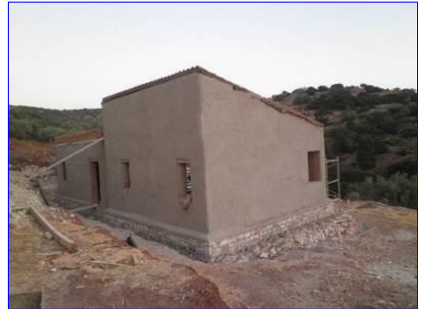
Φωτογραφίες από το τρίτο στάδιο σοβατίσματος «Φινίρισμα»
