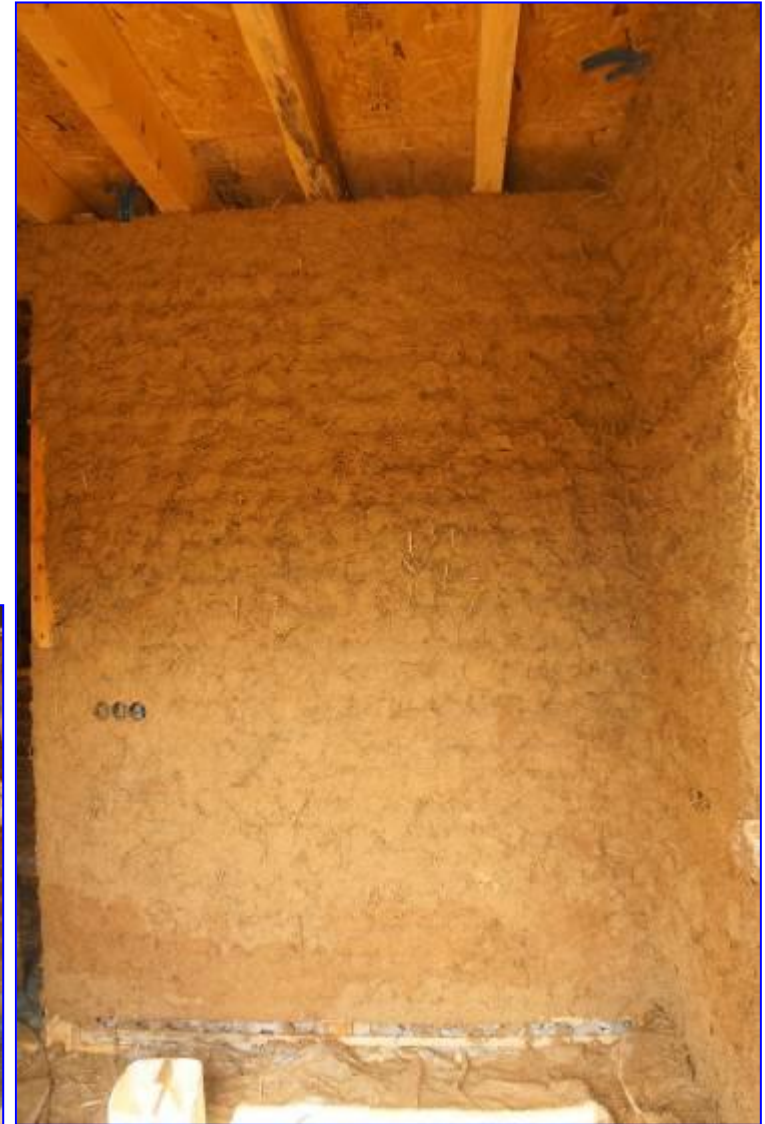
Φωτογραφίες από το πρώτο στάδιο σοβατίσματος «Βρώμικο»
