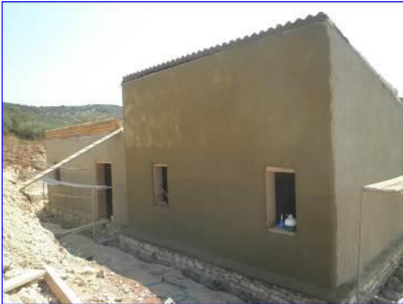
Φωτογραφίες από το τρίτο στάδιο σοβατίσματος «Φινίρισμα»
