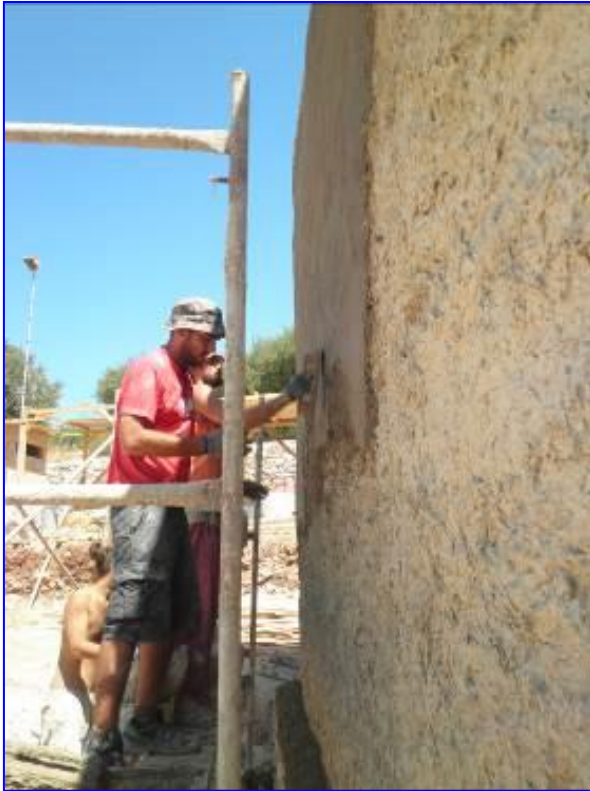
Φωτογραφίες από το δεύτερο στάδιο σοβατίσματος «Εξομάλυνση»
