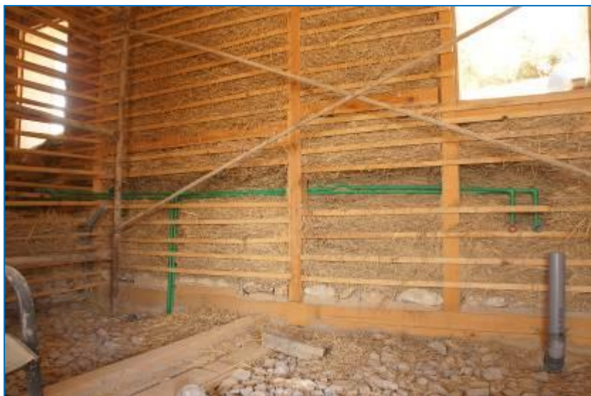
Αριστερά: φαίνεται η υδραυλική εγκατάσταση στην κουζίνα
