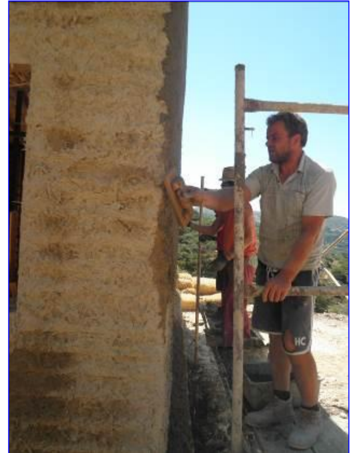
Φωτογραφίες από το δεύτερο στάδιο σοβατίσματος «Εξομάλυνση»
