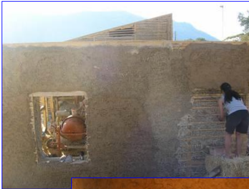
Φωτογραφίες από το πρώτο στάδιο σοβατίσματος «Βρώμικο»
