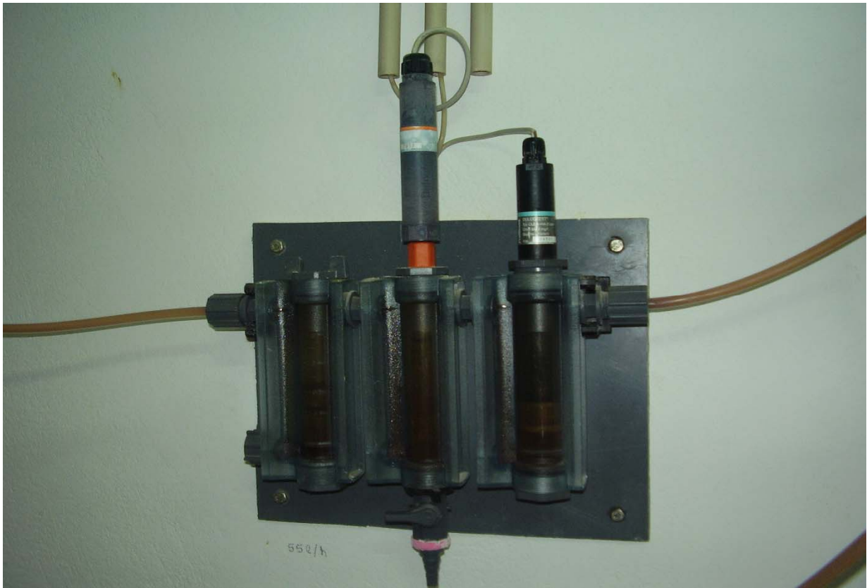
Εικόνα 17. Συγκροτήματα Χλωρίωσης Δεξ. Βαντέ, Αισθητήρια Μέτρησης HOCL, PH, T.
