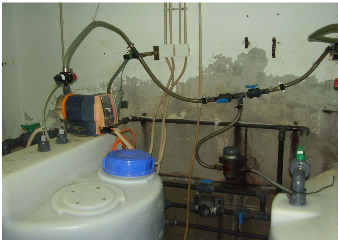
Εικόνα 13. Συγκρότημα Προχλωρίωσης Δεξ. Βαντέ
