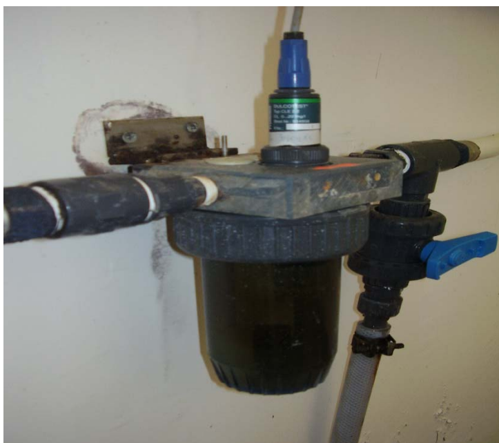
Εικόνα 21. Αισθητήρας Μέτρησης HOCL Αγωγού Προς Στρατόπεδο Αγιάς. Αγιάς.
