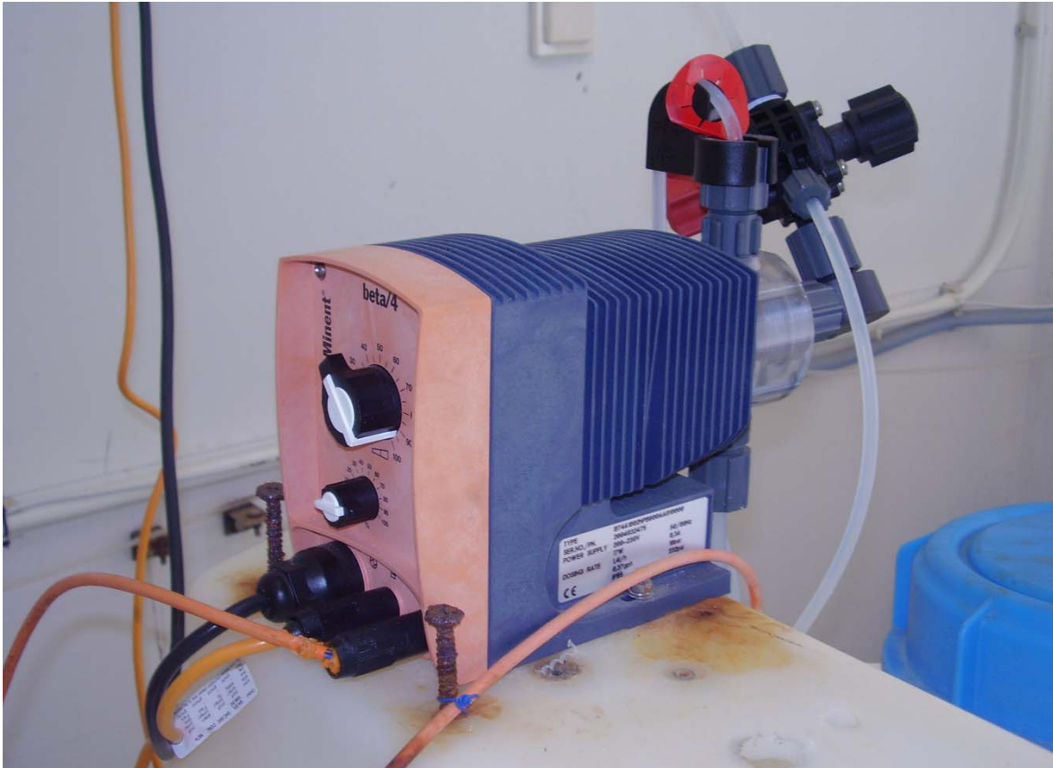
Εικόνα 19.Ροοαναλογικό Συγκρότημα Χλωρίωσης Αγωγού Προς Στρατόπεδο Αγιάς.
