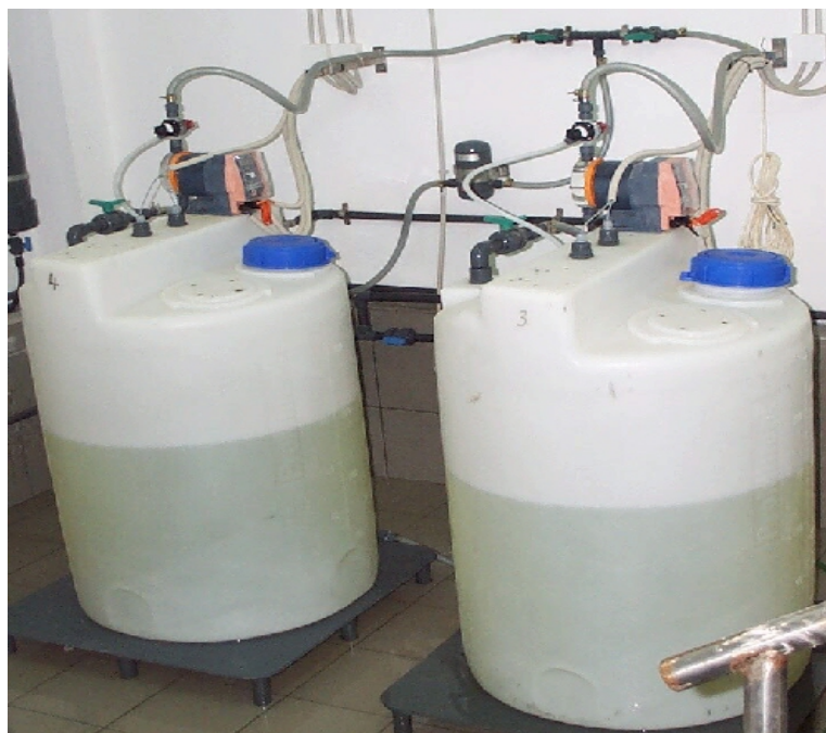
Εικόνα 6. Δοχεία και Αντλίες χλωρίωσης
