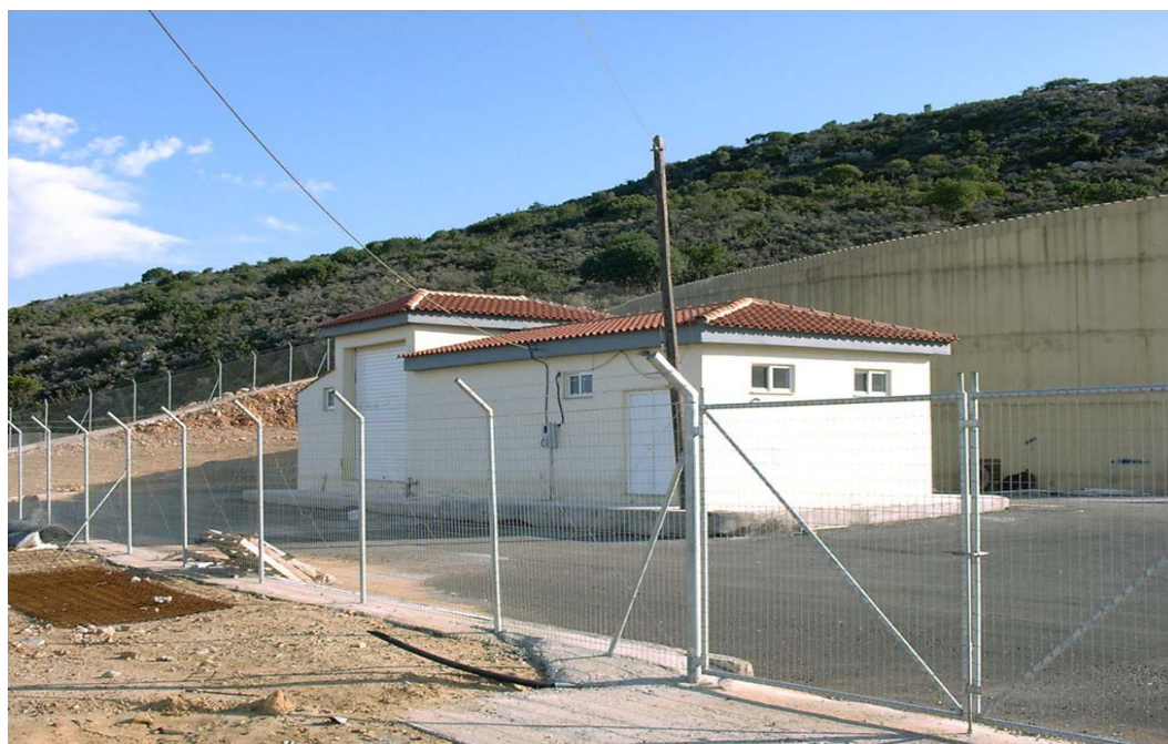
Εικόνα 10. Κτίριο Ηλεκτρικών Πινάκων Δεξ. Βαντέ και Χλωρίωσης
