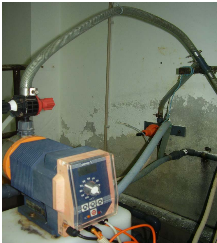
Εικόνα 15. Δοσομετρική Αντλία Χλωρίωσης Δεξ. Βαντέ
