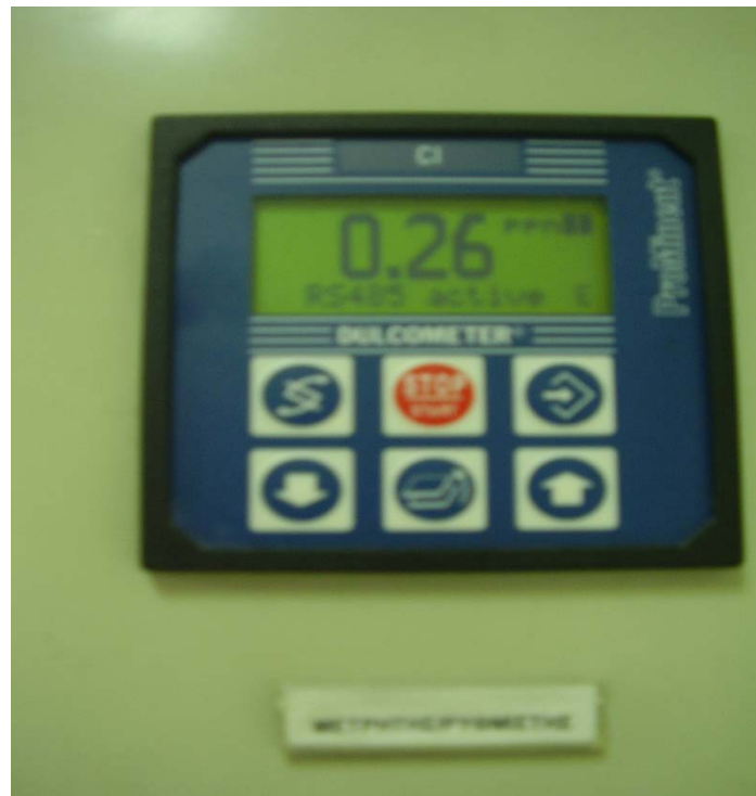
Εικόνα 8. Ελεγκτής PID Αντλιών Χλωρίωσης Αγωγού Φ350 Αγιάς
