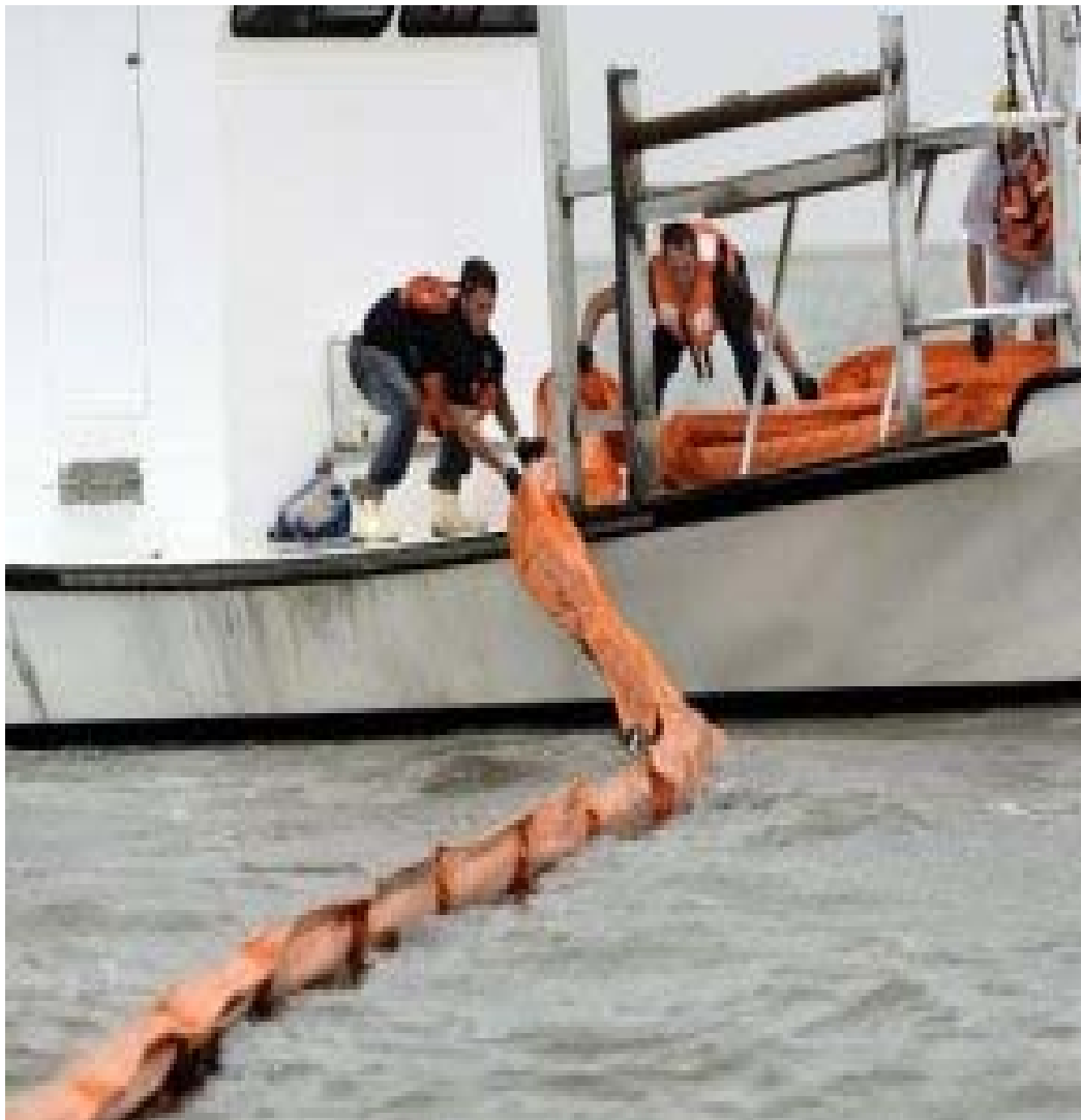
Σχήμα 3. 10 Τοποθέτηση φράγματος περισυλλογής (Μαρίνος Ιωάννου, Προϊστάμενος Ναυτικής Υπηρεσίας, Ρύπανση της θάλασσας από πετρελαιοειδή)
