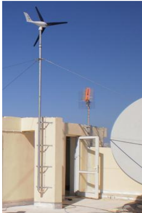
(Εικόνα 8.9) Ολοκλήρωση εγκατάστασης της Α/Γ.
