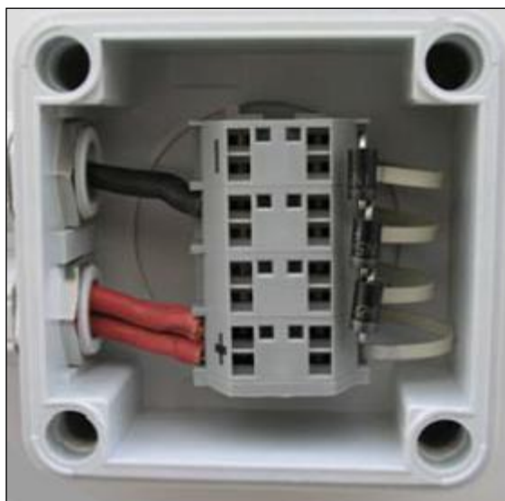
(Εικόνα 8.3) Υδατοστεγές κουτί στο πίσω μέρος του Φ/Β πλαισίου
