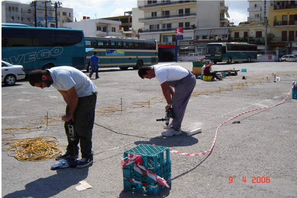
Σχήμα 5. Φωτογραφία από την περιοχή 1, κατά τη διάρκεια της διάτρησης της ασφάλτου για την εκτέλεση των γεωηλεκτρικών τομογραφιών όπως φαίνεται στη φωτογραφία.
