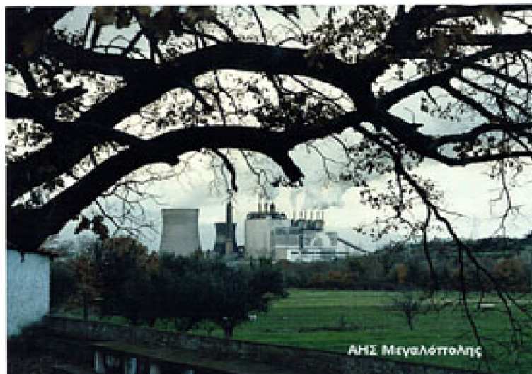
Σχήμα 1.2: Ατμοηλεκτρικός σταθμός Μεγαλόπολης.
