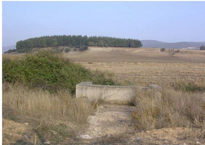
Εικόνα 7.2 Γενική άποψη του φρεατίου εξόδου των υγρών αποβλήτων στην νοτιοδυτική πλευρά της ΒΠΠΕ.
